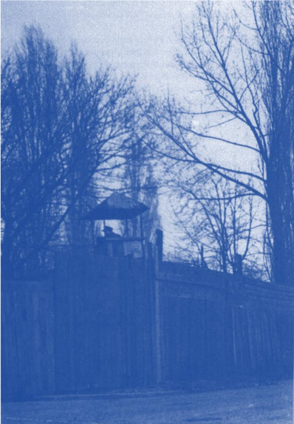
396 (Abb. 40) Aussenzaun des Sperrgebiets um das Untersuchungsgefängnis Hohenschönhausen, 1956
