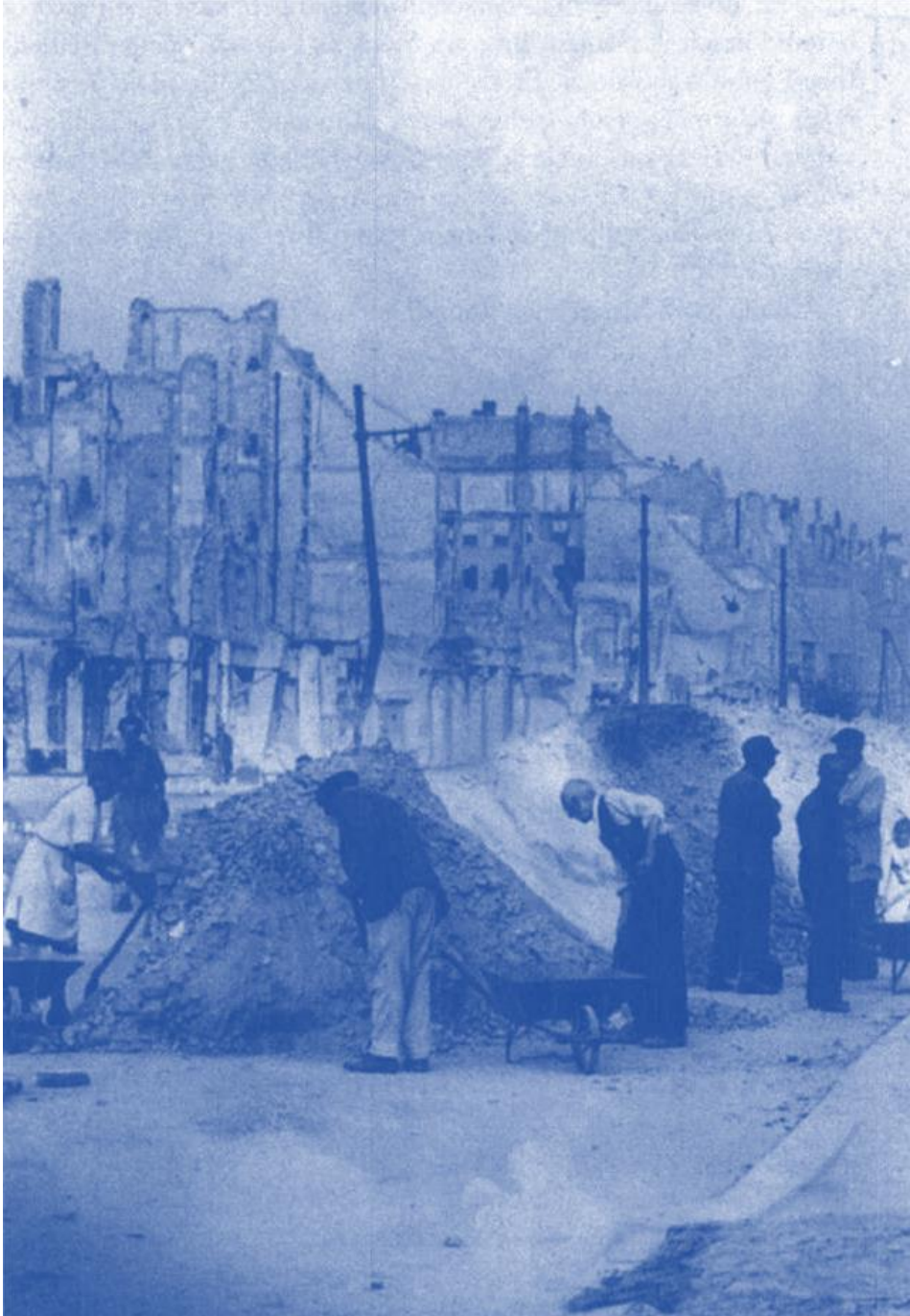
344 (Abb, 36) Enttrümmerung der Frankfurter Allee im August 1946
