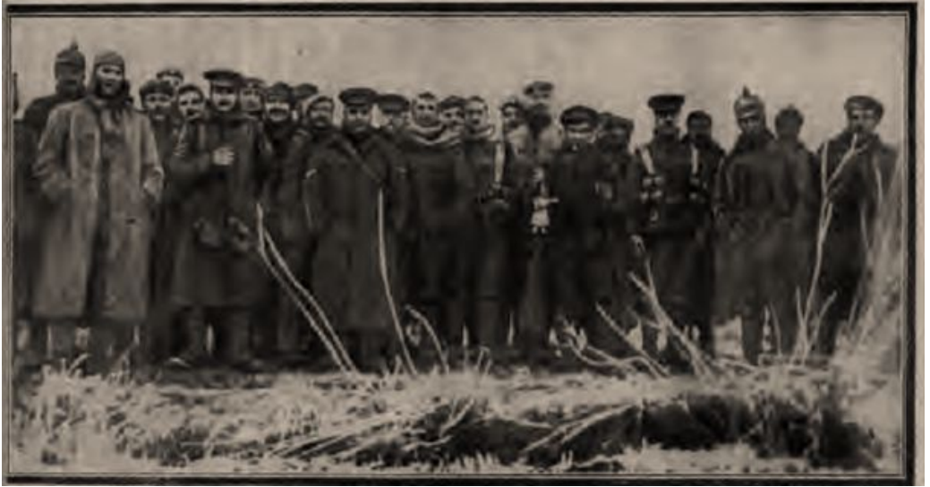
Das Foto erregte Aufsehen. Veröffentlicht am 8. Januar 1915 auf der ersten Seite des «Daily Mirror» unter der Schlagzeile: «Eine historische Gruppe: Britische und deutsche Soldaten gemeinsam fotografiert.»
