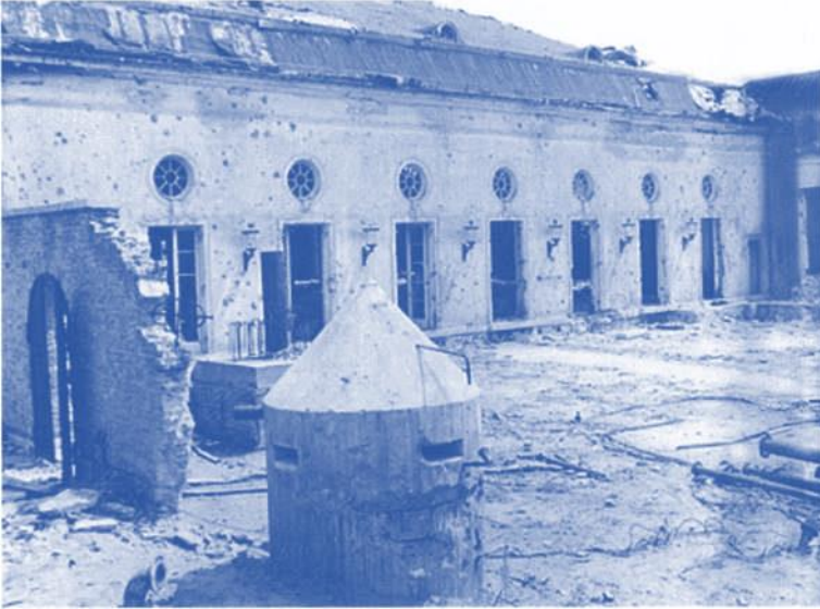
«Der Krieg ist verloren» – Reichskanzlei im Juli 1945: Blick vom Auswärtigen Amt auf die Betondecke des «Führerbunkers» mit dem Abgasrohr des Notstromaggregats. Im Hintergrund der 1935 erbaute Festsaal, unter dem sich der Vorbunker befand
