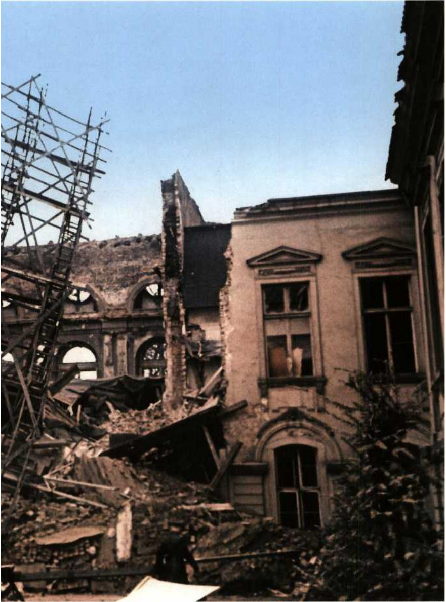
Von Bomben getroffene Reichskanzlei, rechts Hitlers zerstörte Wohnung im ersten Obergeschoss, etwa März 1945
