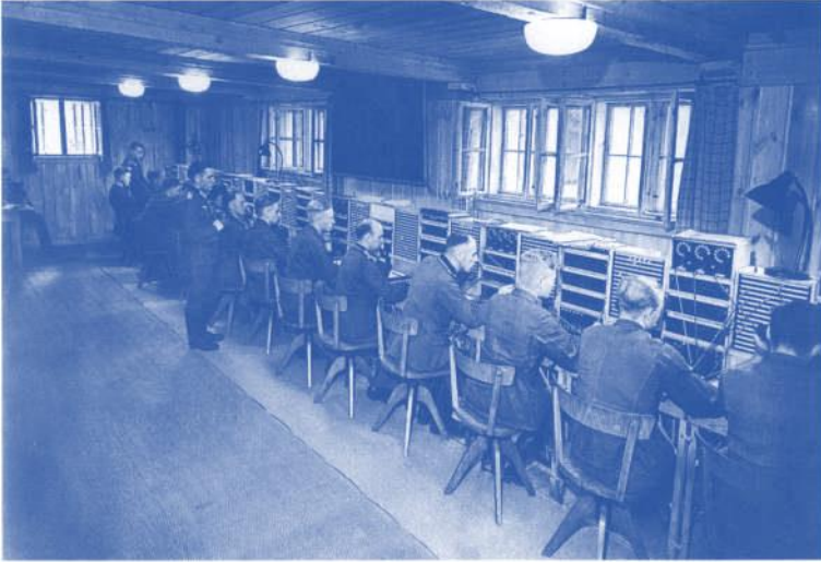
Telefonzentrale in der «Wolfsschanze» 1942/1943 – bis ins Detail alles sorgfältig geplant
