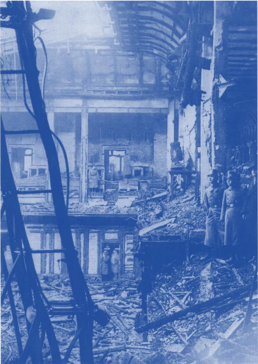
Blick in den ausgebrannten Plenarsaal.
