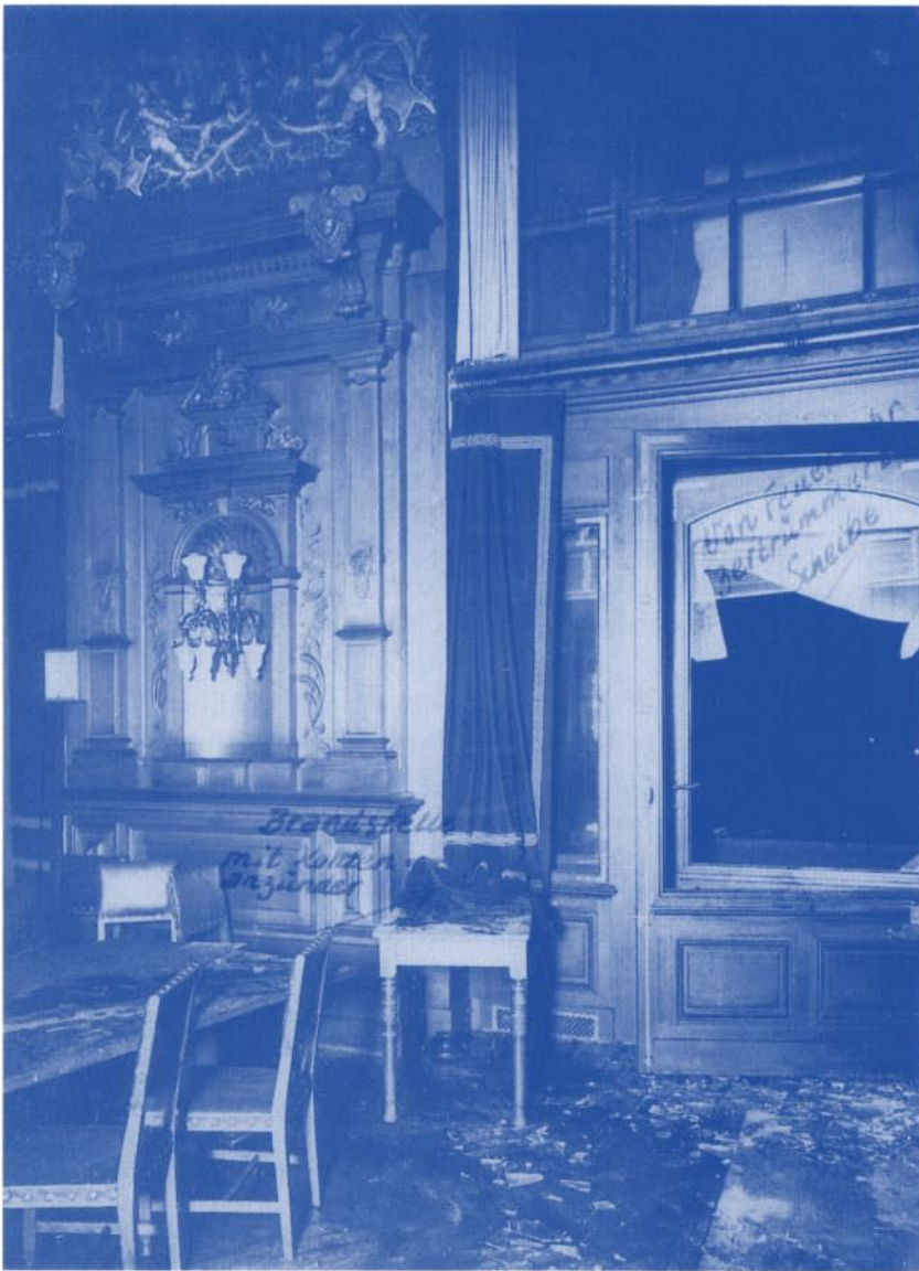
Von der Feuerwehr eingeschlagene Scheibe zur Restauration. Manipuliertes Polizeifoto aus den Ermittlungsakten. Rechts davon wäre das angebliche Einstiegsfenster van der Lubbes zu sehen gewesen, dieser Teil des Fotos fehlt.
