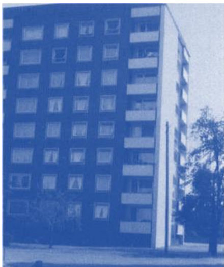
1961 zogen wir überglücklich in unsere 3-Zimmer-Wohnung in der 2. Etage. Sie lag im zweiten fertiggestellten Hochhaus der Eisenbahnersiedlung Hannover-Leinhausen.
