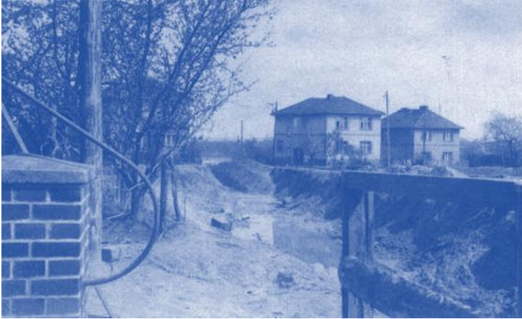
Der Bau des Eisenbahnaussenrings in Berlin-Altglienicke, Ortsteil Falkenberg 1951. Die Trasse führt unmittelbar an unserem Haus vorbei und hat einen Teil unseres Gartens verschlungen. Im Vordergrund sind provisorisch verlegte Schienen zu sehen, auf denen Loren den Erdausbub, Materialien und anderes transportierten. Die Aufnahmen hat meine Schwester Irmgard Weimar im Mai 1951 gemacht. Meine Familie und ich wohnen noch heute in diesem Haus.
