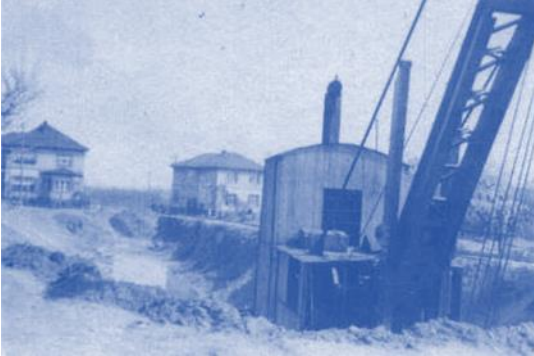
Unablässig frisst sich der Bagger durch die Alemannenstrasse. Das Haus rechts sollte weichen.
