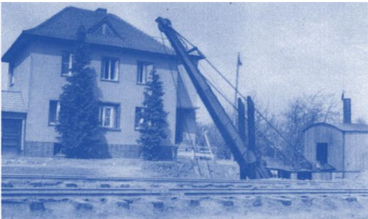
Der Bau des Eisenbahnaussenrings in Berlin-Altglienicke, Ortsteil Falkenberg 1951. Die Trasse führt unmittelbar an unserem Haus vorbei und hat einen Teil unseres Gartens verschlungen. Im Vordergrund sind provisorisch verlegte Schienen zu sehen, auf denen Loren den Erdausbub, Materialien und anderes transportierten. Die Aufnahmen hat meine Schwester Irmgard Weimar im Mai 1951 gemacht. Meine Familie und ich wohnen noch heute in diesem Haus.
