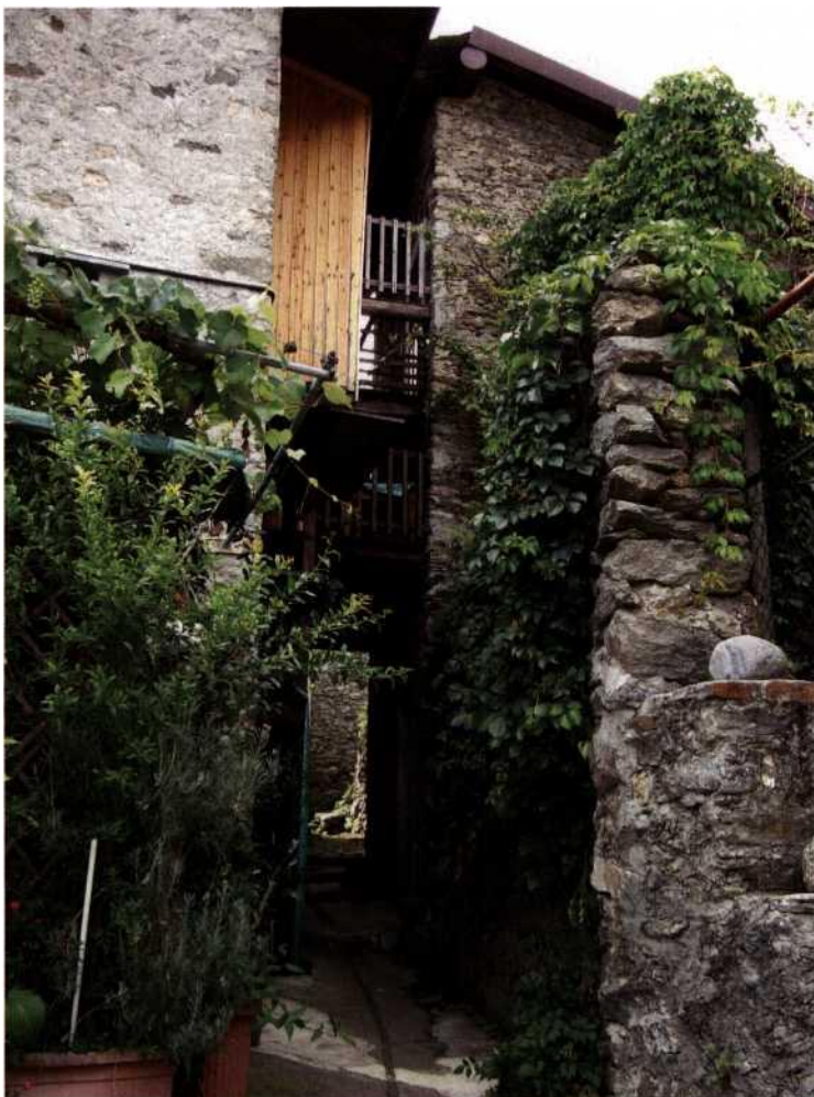
«Obere Gasse» in San Bello; direkt über der Gasse der Balkon, welcher vom Wohnhaus der Familie Della Nave (Gebäude links) zur «Käsekammer» (Gebäude rechts) führt.
