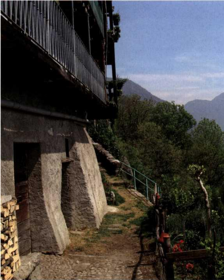
«Untere Gasse» mit Kellergeschoss des Hauses Della Nave in San Bello. Der zweite Eingang führt in den Stall.
