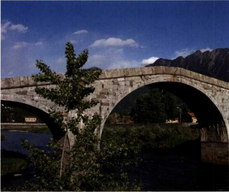
Der «Ponte di Ganda» überspannt die Adda. Links ist das Elektrizitätswerk zu erkennen.
