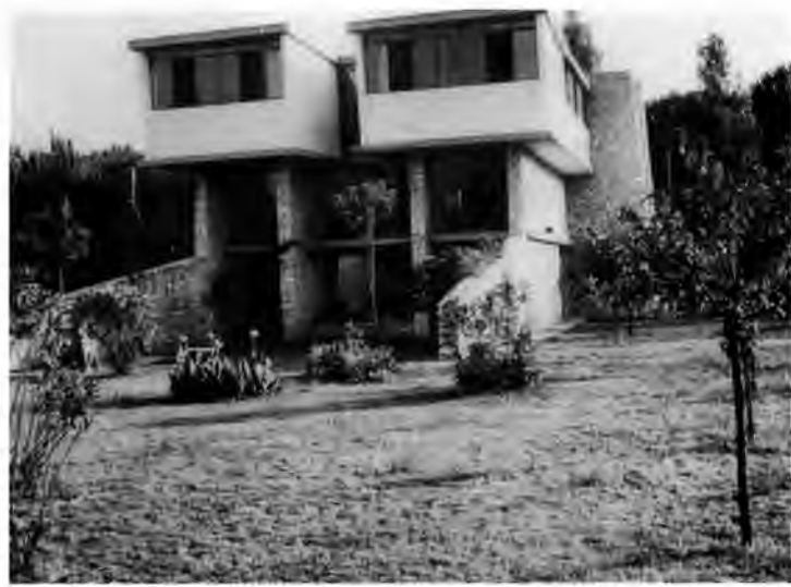
Das Sommerhaus in Forte dei Marmi, erbaut vom Architekten Leonardo Ricci
