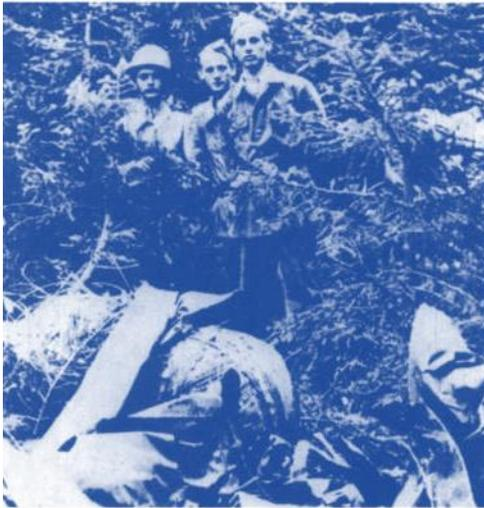
Absturzstelle einer deutschen Flugbombe ohne Sprengladung auf schwedischem Hoheitsgebiete. Deutlich sind die kugelförmigen Pressluftbehälter zu erkennen.
