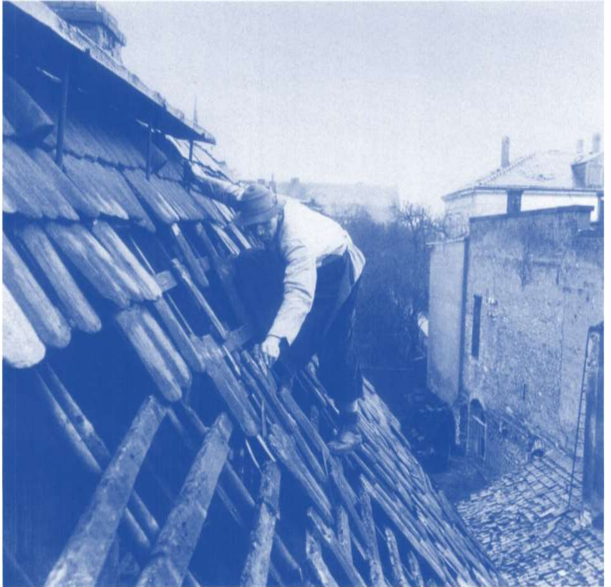
Kurt Ueberschär (1901-1988) Notreparatur des Hauses Dohner Strasse 5, Februar 1945.
