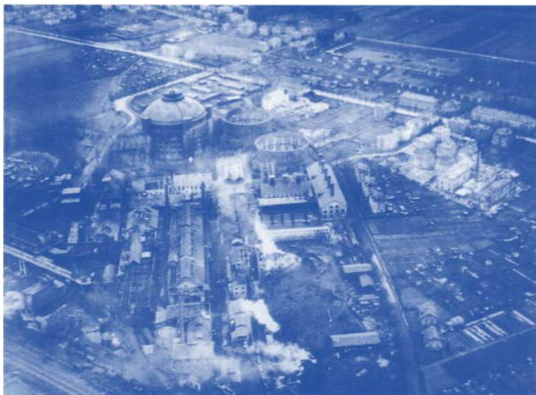
Gaswerk Reick, dahinter Fremdarbeiterlager und Winterbergstrasse, vorn Eisenbahngleise.
