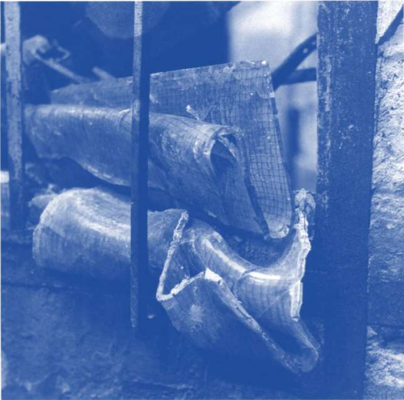
Richard Peter sen. (1895/1977) Teil eines Stahlfensterrah- mens mit Sicherheitsgitter und geschmolzenen Glasscheiben.
