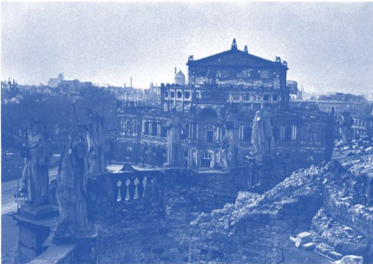
Die einstige Pracht – ein Trümmerfeld: Blick vom Dach der Hofkirche zur Staatsoper.
