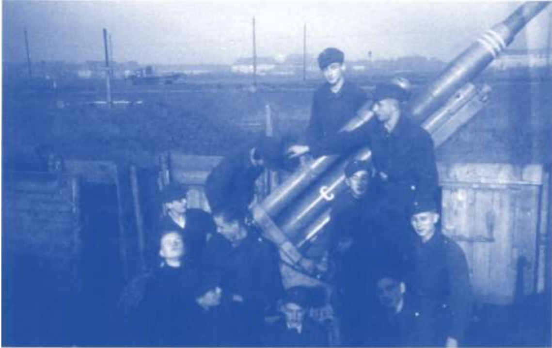
Karl Palitzsch (1928-2003) Flakhelfer in der Stellung der Heimatflakbatterie 238/IV, Liebstädter Strasse, 1944.
