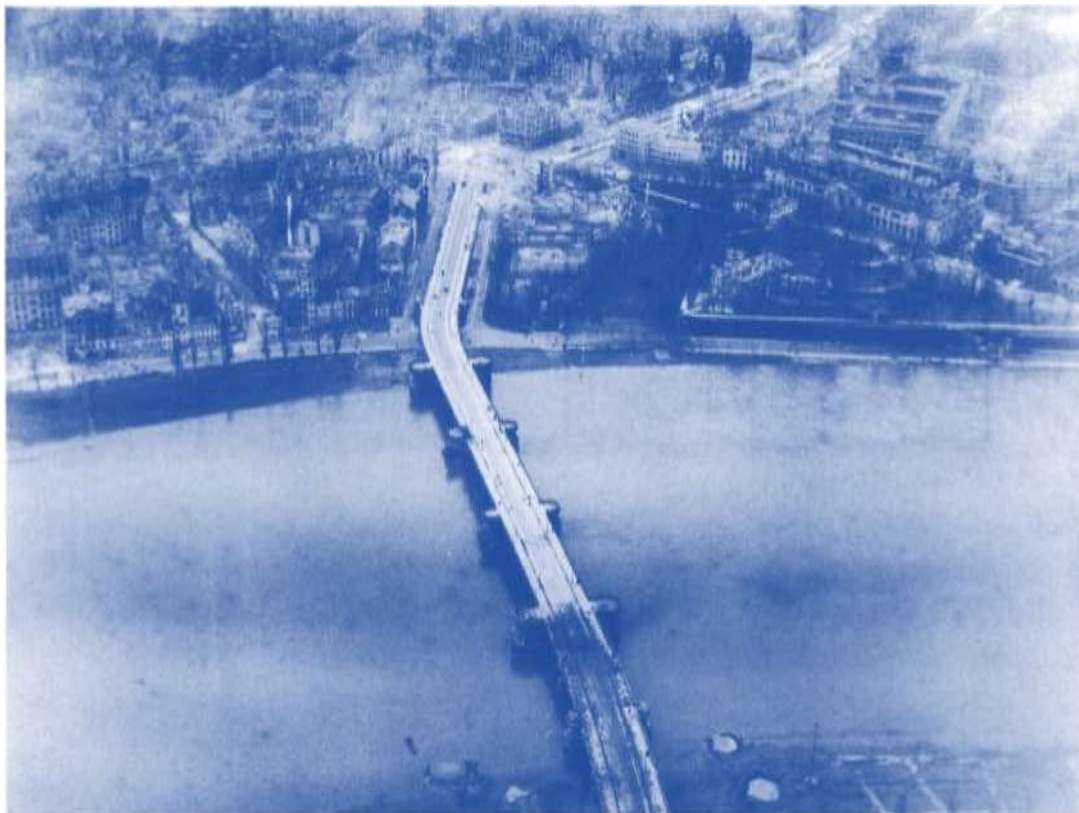
Carolabrücke mit Bomben-trichtern, rechts Brühlsche Terrasse mit Belvedere und Albertinum.
