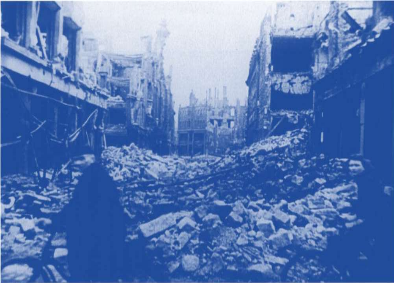
Blick durch eine völlig vernichtete Strasse in der Innenstadt.
