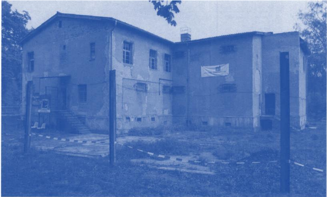
Gebäude des ehemaligen MGB-Gefängnisses in Potsdam-Leistikowstrasse (Facts & Files 2005).
