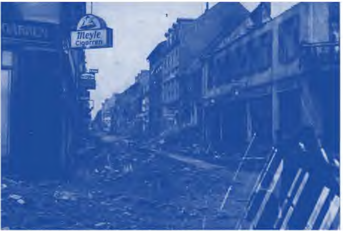
147 Die Waldstrasse (Ecke Sophienstrasse) ist total zerstört.
