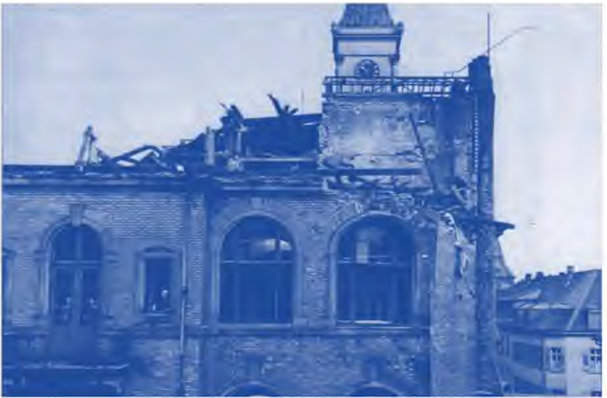
143 Das Polizeipräsidium (Rückseite), von Sprengbomben getroffen.
