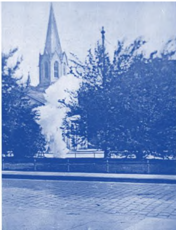
27 Eine Warnbombe detoniert vor der Christuskirche.
