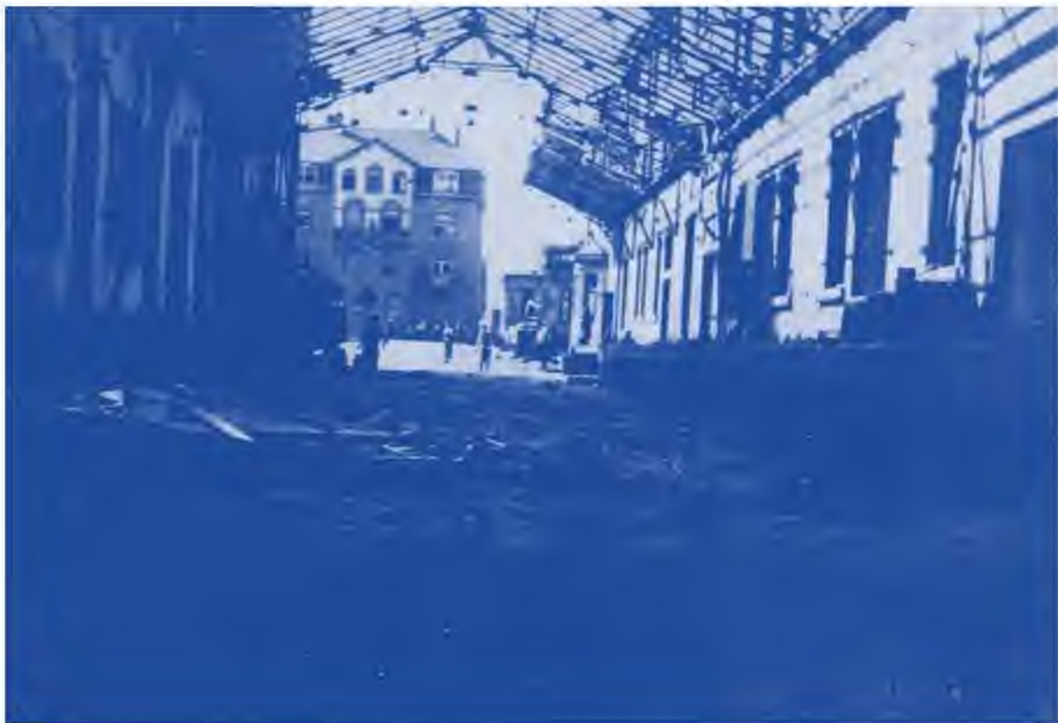
24 Bombenschäden im Lebensbedürfnisverein in der Roonstrasse,
