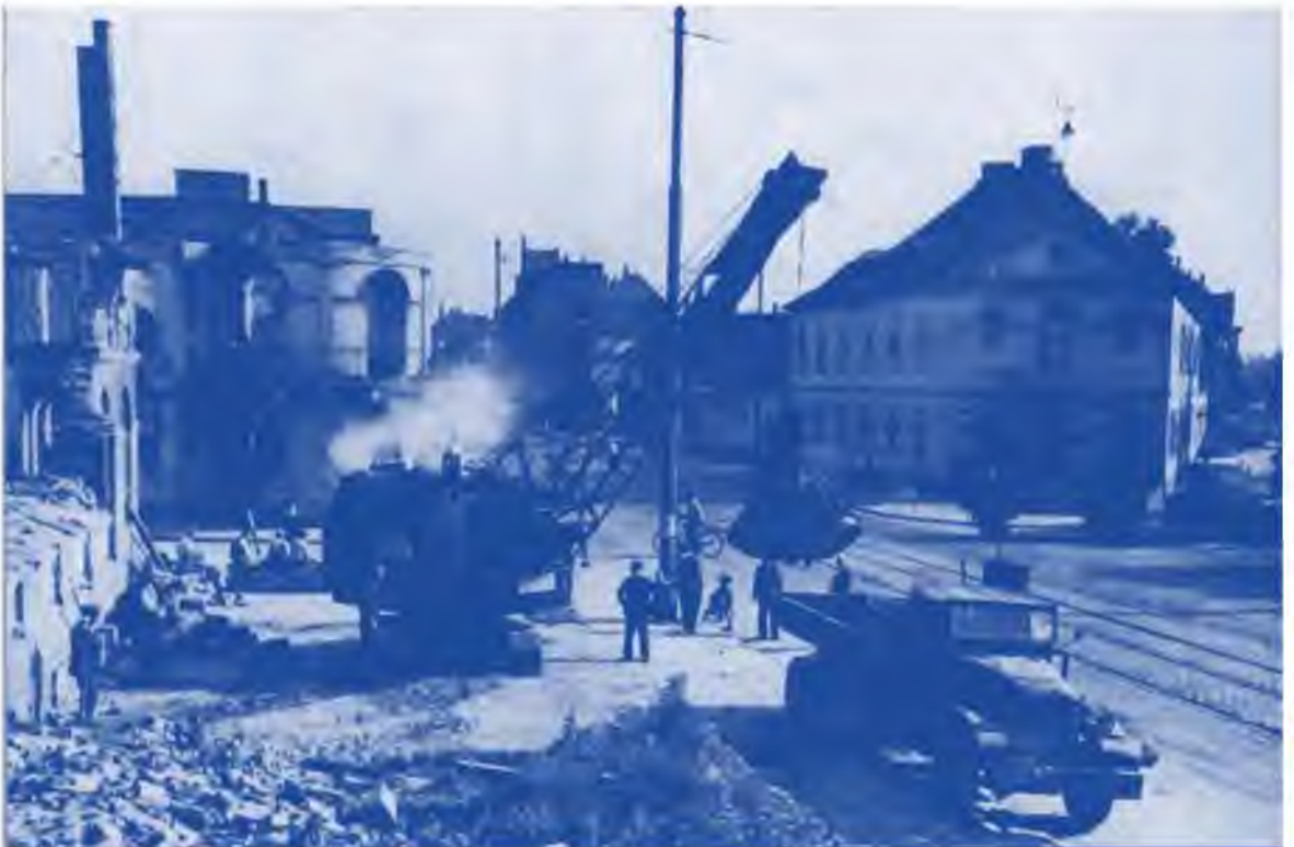
176 Am Karlstor ist die Künstlerhaus-Ruine bereits freigelegt.
