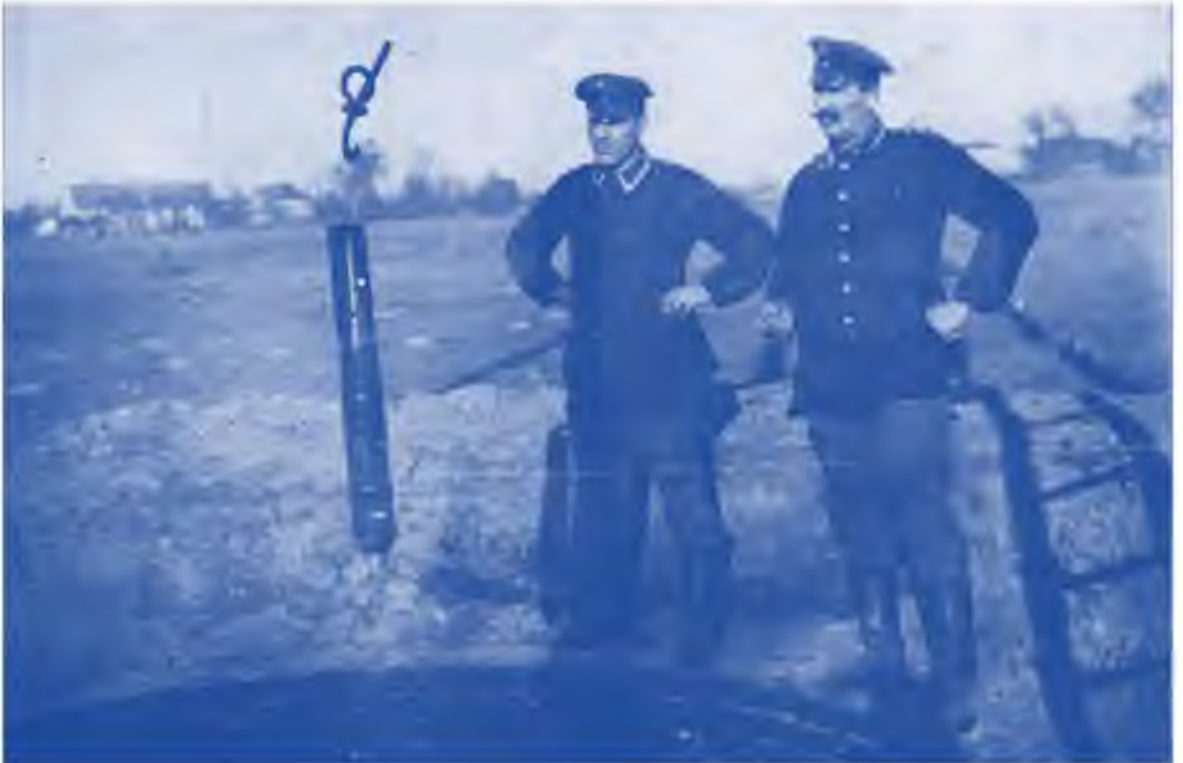
60 ... wird in einem Schacht am Rande des Flugplatzes erprobt.
