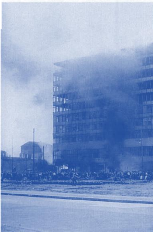
Das teilweise leerstehende Columbus-Haus am Potsdamer Platz wird von Demonstranten in Brand gesteckt.
