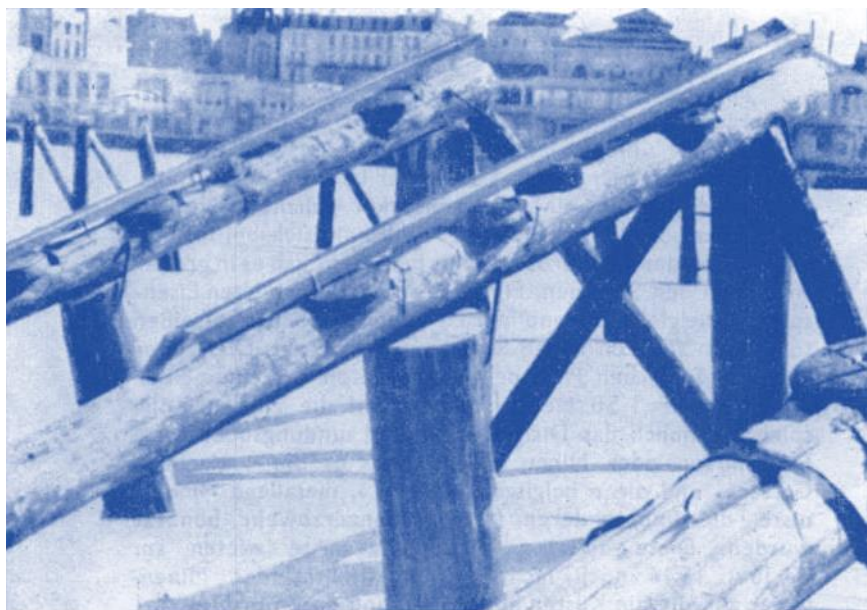
Holzpfähle mit flachen Minen und Feuerbalken
