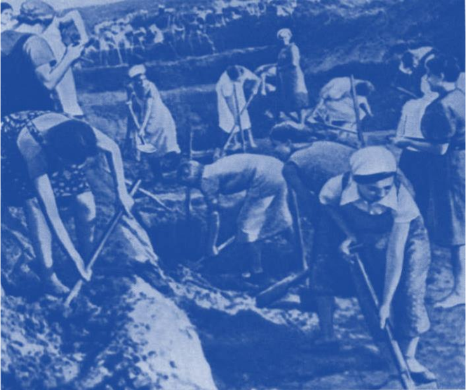
Befestigungsarbeiten vor Leningrad. Juli 1941
