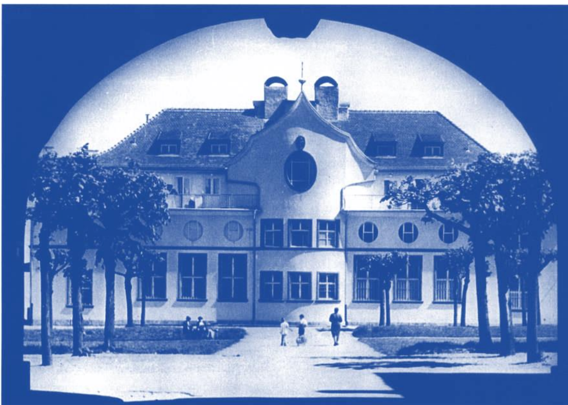
Mittelbau des ehemaligen Krankenhauses der Israelitischen Gemeinde nach dem Wiederaufbau und Umbau 1952. Damals als Speisesaal des Altersheims und Kindergarten der Jüdischen Gemeinde genutzt.
