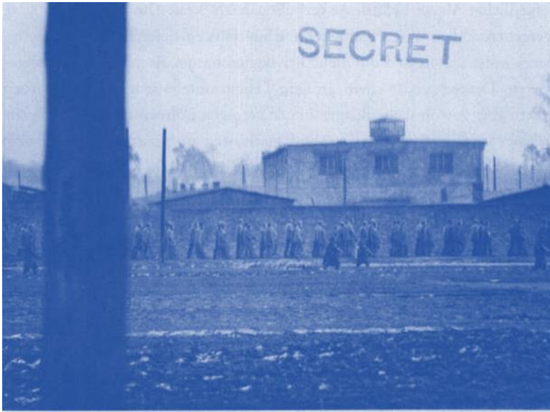
Abb. 5. Eine Kolonne von Insassen des Lagers Jaworzno
