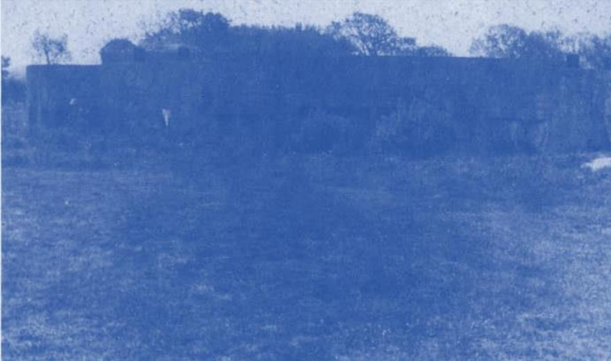
Die Geschützstände der Batterie Hamburg bestanden aus einer offenen Bettung, die an den beiden Seiten von einer ca. 3 Meter hohen Betonmauer umgeben waren. An der Rückseite stand der eigentliche Bunker. Von dort gelangte man durch zwei seitlich angeordnete Tore an das Geschütz.
