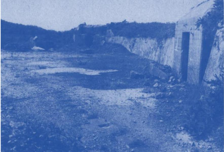
Die offenen Bettungen der Eisenbahngeschützstellung von Auderville-Laye waren halbkreisförmig auf beiden Seiten der Zufahrt umschlossen. In der Betonmauer waren die Eingänge zu unterirdischen Munitionsdepots und Schutzräumen für die Bedienungsmannschaft.
