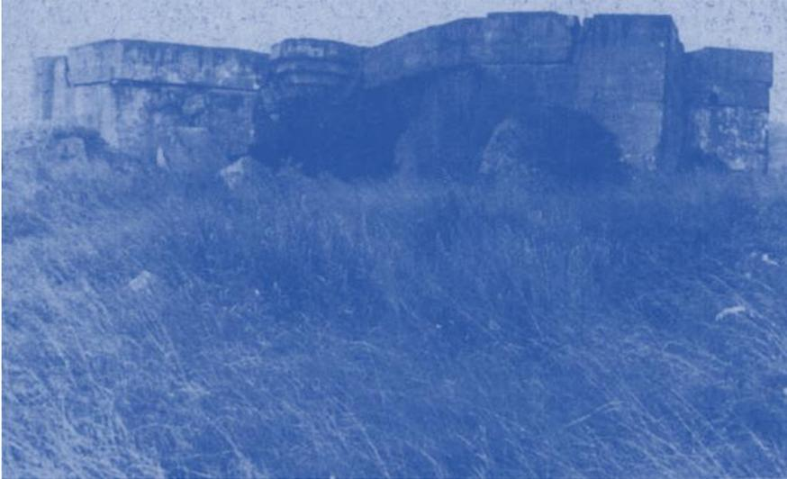
Die Geschützkasematten der Batterie «Lindemann» haben eine Länge von 35 Metern und eine Breite von 30 Metern. Die Höhe der Öffnung des Kampfraumes beträgt 12 Meter. (Kasematte «Anton»)
