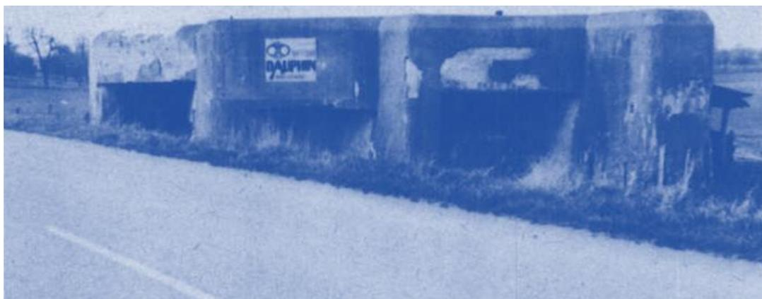
Kampfanlage mit einseitiger Flankierung durch Pak und MG ohne Panzerglocke, von den Franzosen als Blockhaus B bezeichnet, kommt in allen Abschnitten vor. Hier in der Gegend von Hatten.
