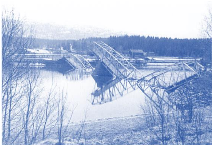
Abb. 23: Der im April 1945 gesprengte Saalachübergang bei Hammerau – Grünau
