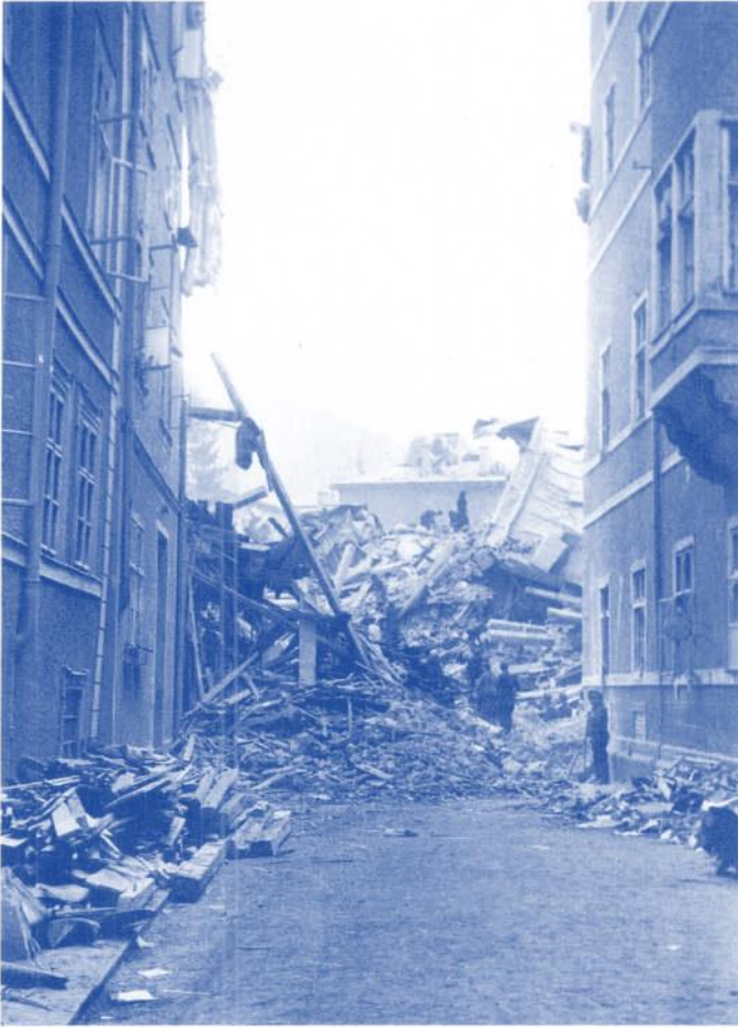
Abb. 11: Das Haus Kaigasse 25 nach einem Bombentreffer, Blick aus der Kapitelgasse
