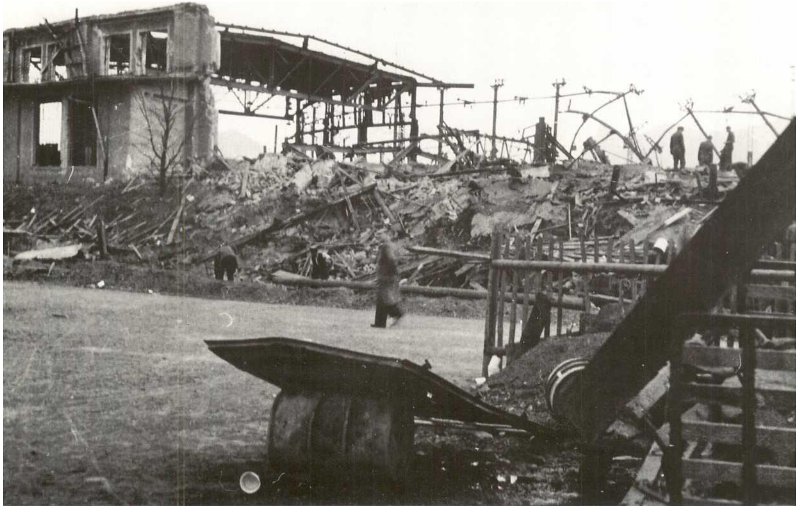
Abb. 2: Die Remise des Salzburger Hauptbahnhofes nach einem Bombentreffer
