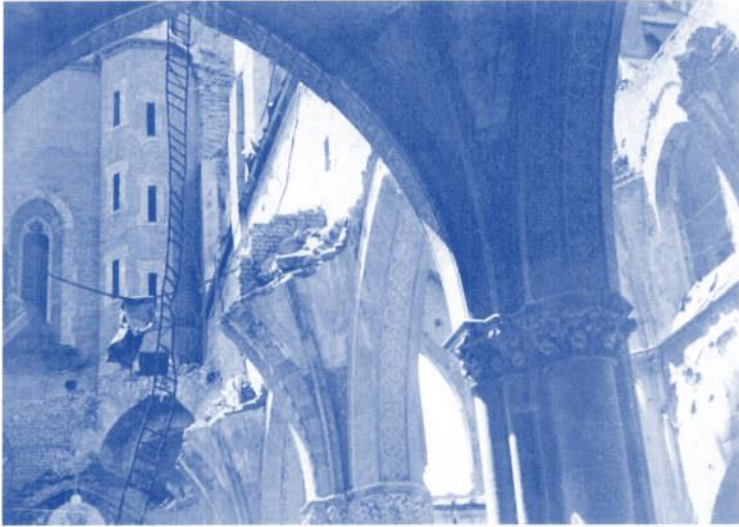
Abb. 8: Durch Bomben zerstörtes Gewölbe des Langhauses der Kirche St. Andrä am Mirabellplatz
