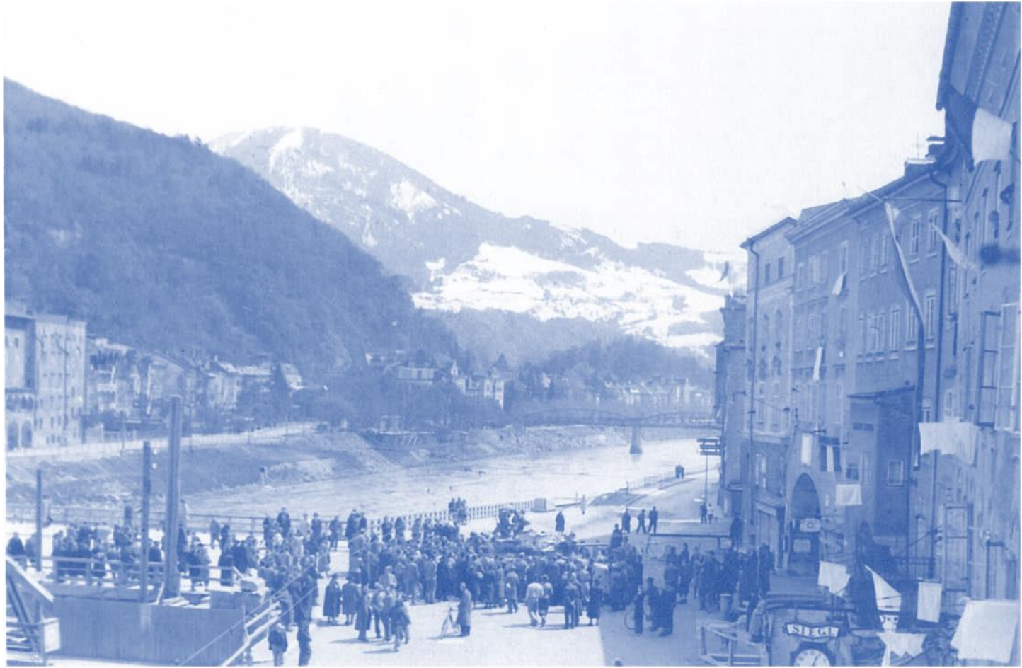
Abb. 31: Blick über den linken Brückenkopf der Staatsbrücke flussaufwärts; im Hintergrund der schneebedeckte Gaisberg, 5. Mai 1945
