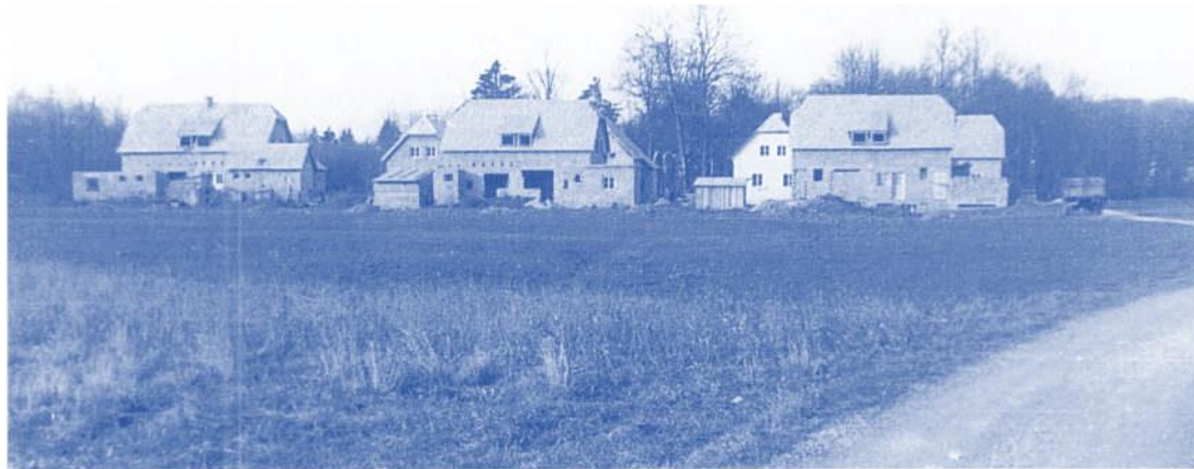
Abb. 148: Caritas-Siedlung (heute St. Peterstrasse in Elsbethen), 1. Bauabschnitt, 1951, grossteils durch Eigenleistungen der zukünftigen Bewohner errichtet
