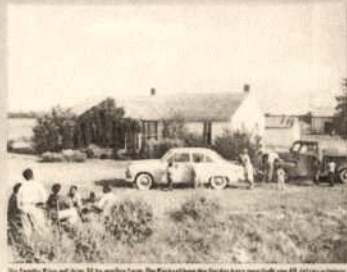
Das Familienhaus auf einer 20 ha großen Farm. Die Bauarbeiten sind beendet und man wohnt nun in 40 Jahren neuem.
