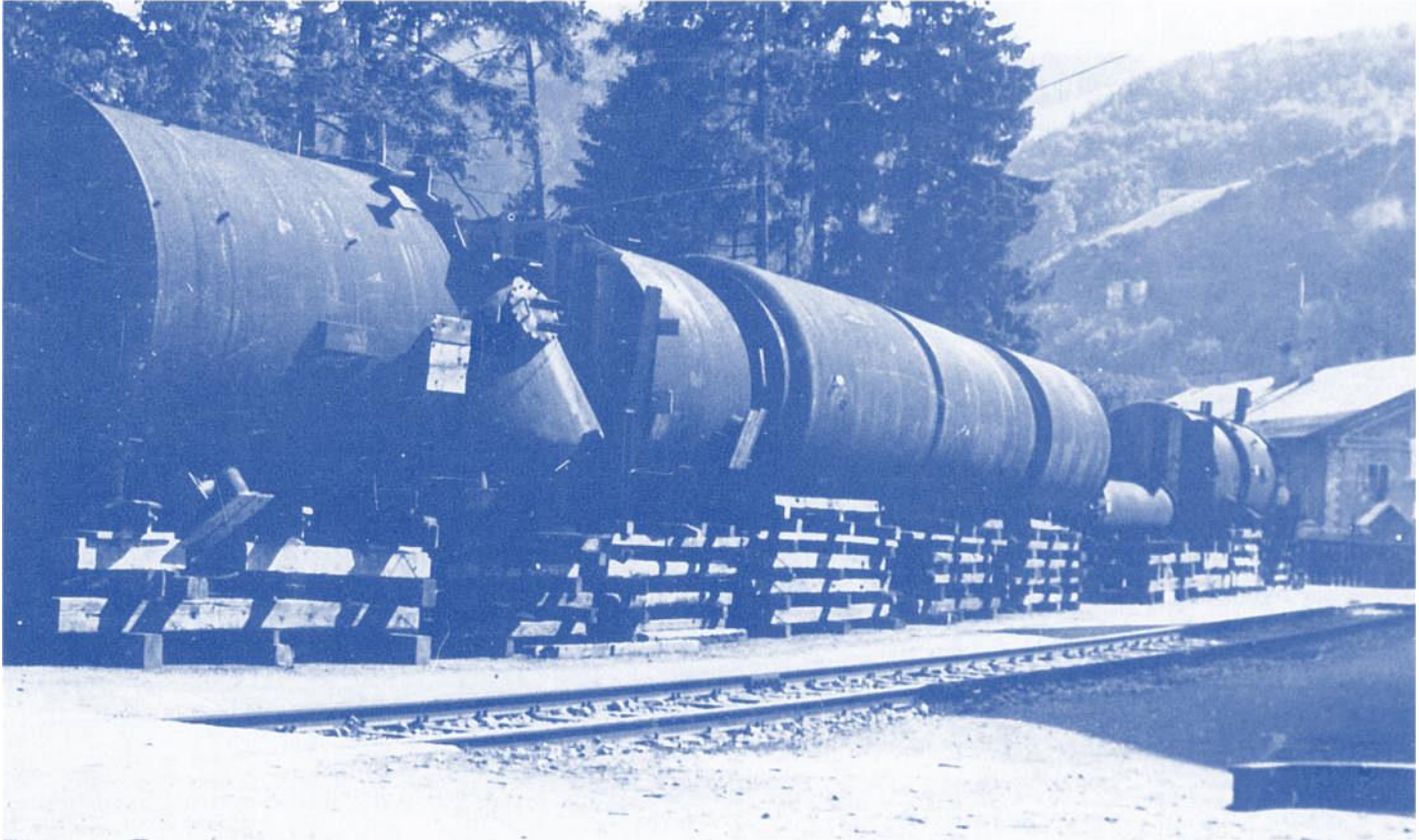
Abb. 198: Saline Hallein, Lieferung der Kesselteile für die neue Thermo-Kompressionsanlage, 1953
