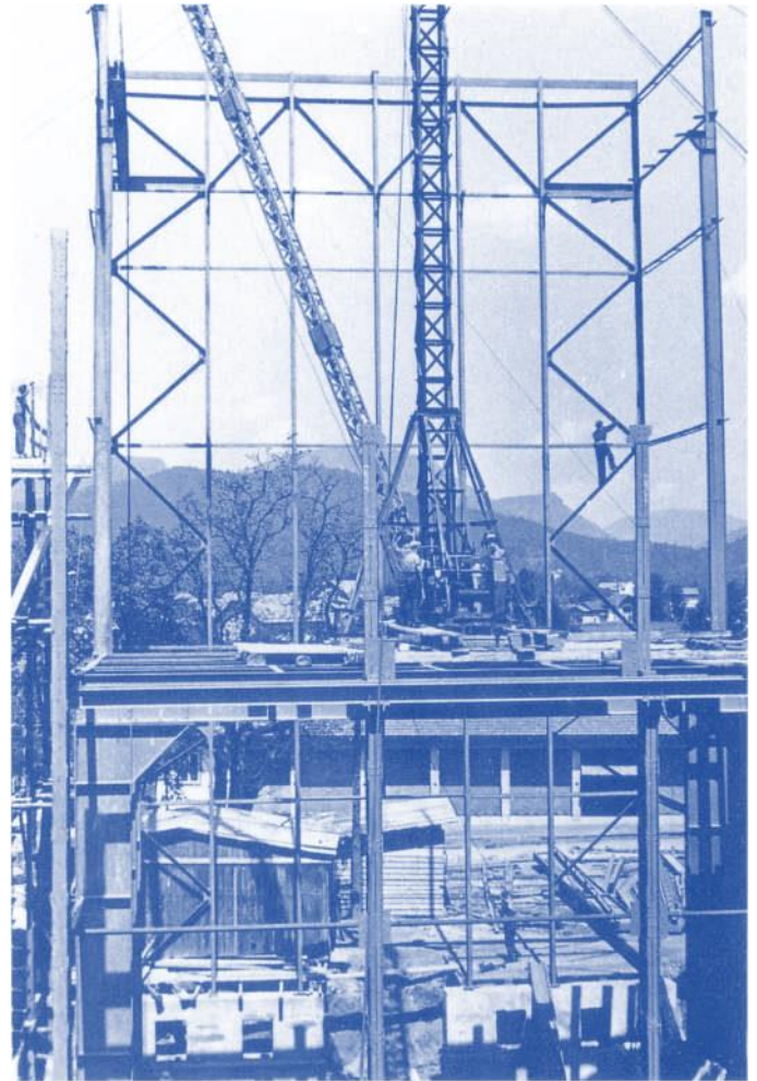
Abb. 201: Stahl und Beton wurden die Baustoffe für Industriebauten, Saline Hallein, 1953
