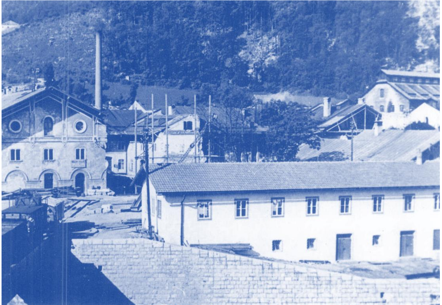
Abb. 197: Bau der Thermo-Kompressionsanlage in der Saline Hallein (Pernerinsel), 1953
