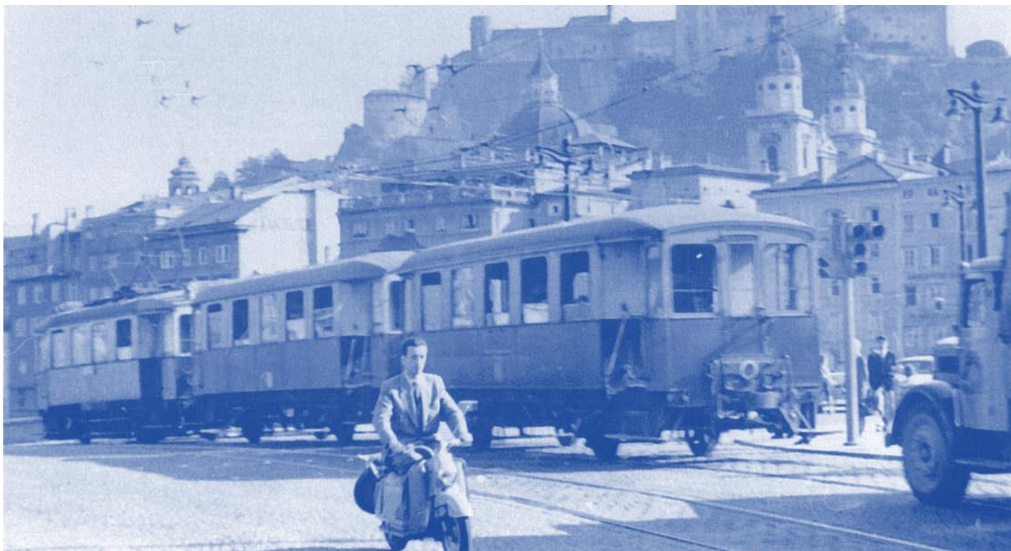
Abb. 178: Die Rote Elektrische am rechten Brückenkopf der Staatsbrücke
