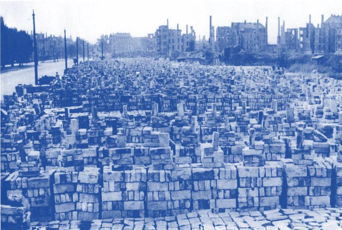
Noch brauchbare Mauersteine wurden gesammelt, von Mörtelresten gereinigt und zu Stapeln geschichtet, um dann zum Wiederaufbau verwendet zu werden.
