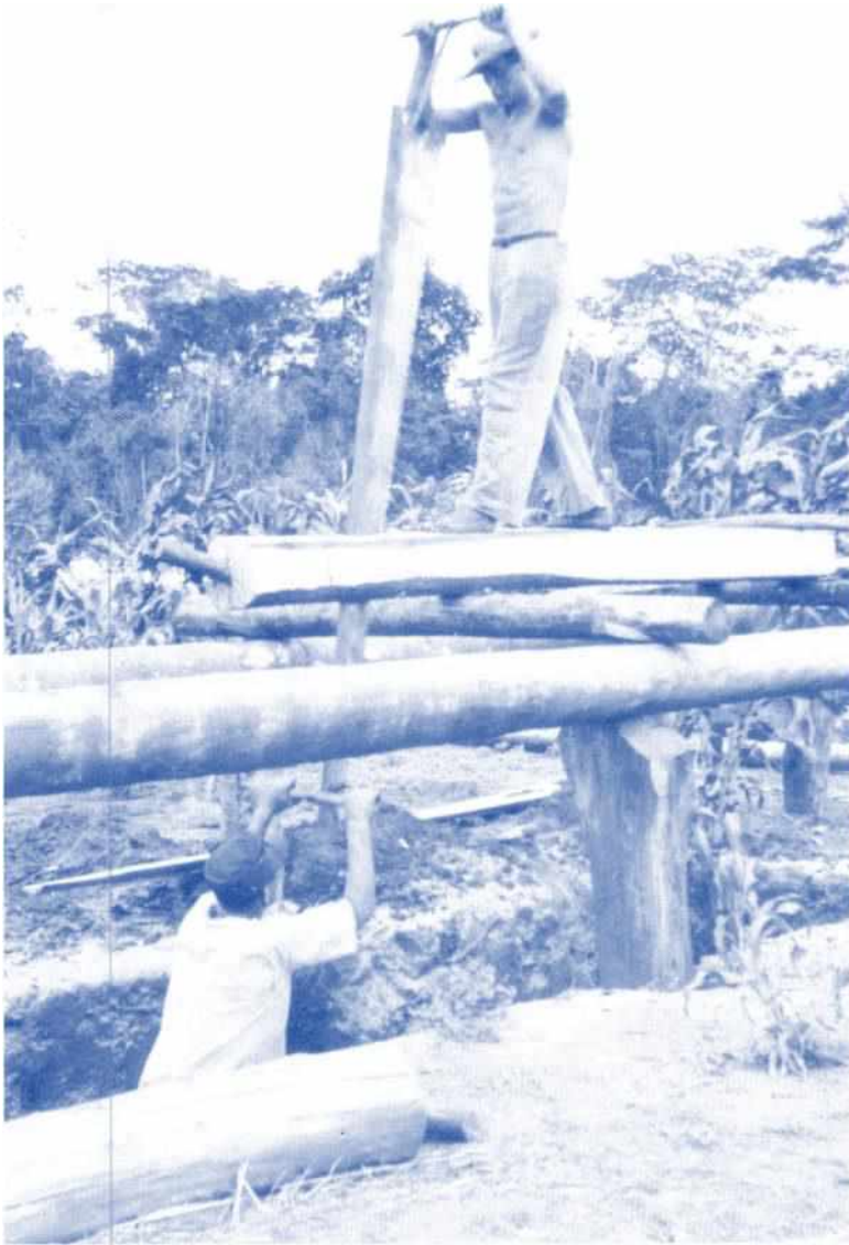
Schwere Arbeit in der Sagemühle! – Die Säge wird von einem Mann oben und einem im Graben gezogen – aber sie standen es durch, Volendam, Paraguay, 1948
