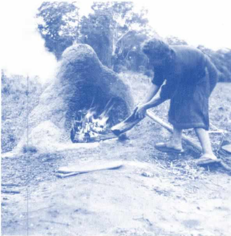
Der erste Ofen, der aus einem Termitenhügel hergestellt wurde. Volendam, Paraguay
