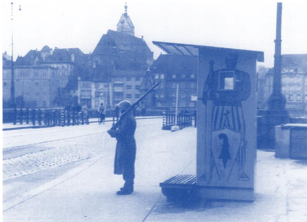
Fig. 25: Guérite de la compagnie territoriale de fusiliers H/127, septembre 1939. Tête de pont sur le Rhin au Petit-Bâle, avec une barricade antichar à moitié installée.
