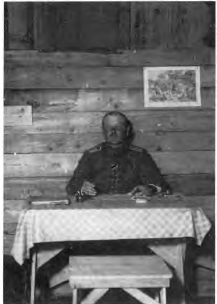
Unterstand in der Champagne, zwei Meter unter der Erde, genannt „Villa Augusta“.
