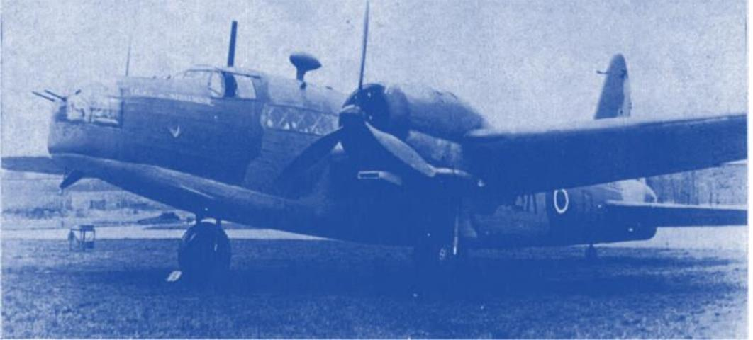
*Oben* Einer der weniger bekannten Typen des Transportkommandos war die Wellington C XVI, eine Abwandlung des Bombers Mk IC mit ausgebautem Gefechtsstand, abgedecktem Bombenschacht, im Rumpf eingebauten Sitzen und Gefechtsstand-Attrappen zur Tarnung der Verteidigungsunfähigkeit. Ähnliche Umbauten der Wellington I und I A erhielten die Bezeichnung C I und C XV.
