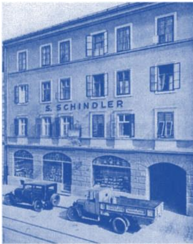
Andreas-Hofer-Strasse 13, der Firmensitz von S. Schindler
