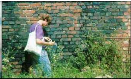
Abbildung 56: Außenmauer Südwest des Zyklon B-Entwesungstraktes des Bauwerkes BW 5b im KL Auschwitz-Birkenau.
