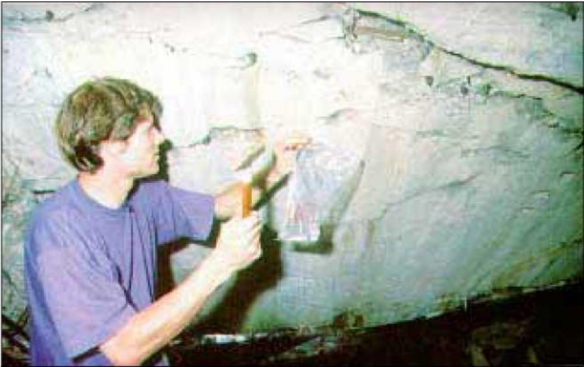
Abbildung 45: Innenaufnahme aus der Ruine des Leichenkellers 1 («Gaskammer») vom Krematorium II. Entnahmestelle der Proben 1 und 2.
