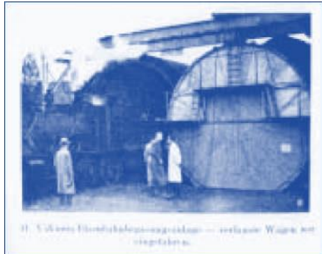
Abbildung 14: Ein verlauster Zug fährt in die Eisenbahnbegasungsanlage Budapest ein. 94
