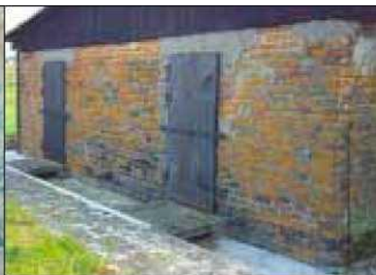
Abbildung 60: Zyklon B-Entwesungsanlage, Kammer II und III (Außenmauer), der Baracke 41 im KL Majdanek. (© Carlo Mattogno 276 )
