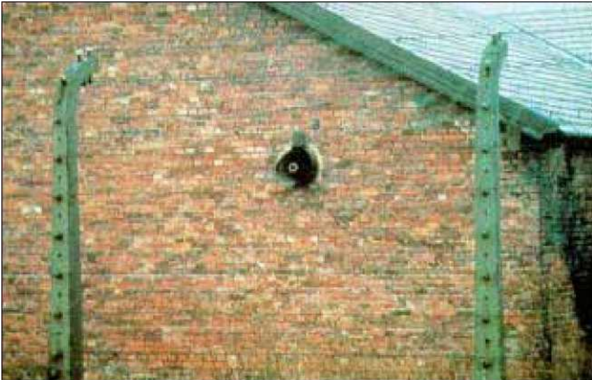
Abbildung 20: Entlüftungsöffnungen des Entwesungstraktes des Bauwerkes BW 5b, heute ohne Apparaturen. Man erkennt darin die Enden der Wasserleitungen, siehe auch Abbildung 19.
