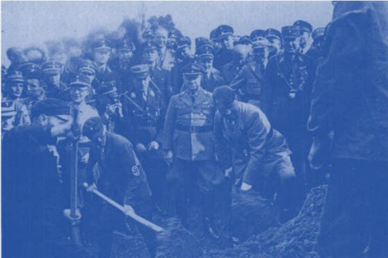
Adolf Hitler beim ersten Spatenstich für die Autobahnstrecke Frankfurt-Darmstadt-Mannheim am 23. September 1933. Der Bau der Reichsautobahnen war nicht Hitlers Idee und nur wenige Arbeitslose fanden dort Beschäftigung.
