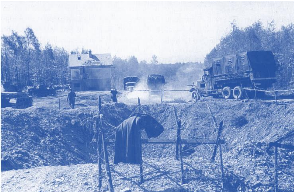
Maison forte «St. Menges». Dieser Grenzbunker sollte die durch einen Sprengtrichter blockierte Zufahrtsstrasse aus den Ardennen über St. Menges nach Sedan sperren
