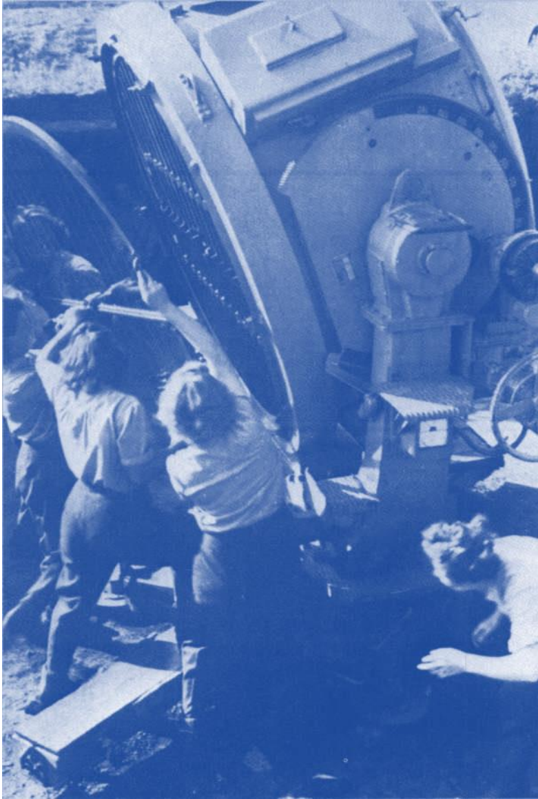
98 Am Ende müssen sogar Arbeitsdienstmädchen, nicht selten erst 16 Jahre alt, die gefährlichen Aufgaben in den Flak-Scheinwerferbatterien übernehmen. Die über 2 m 2 grosse Abschluss-scheibe einzusetzen, verlangt schwerste körperliche Anstrengung.
