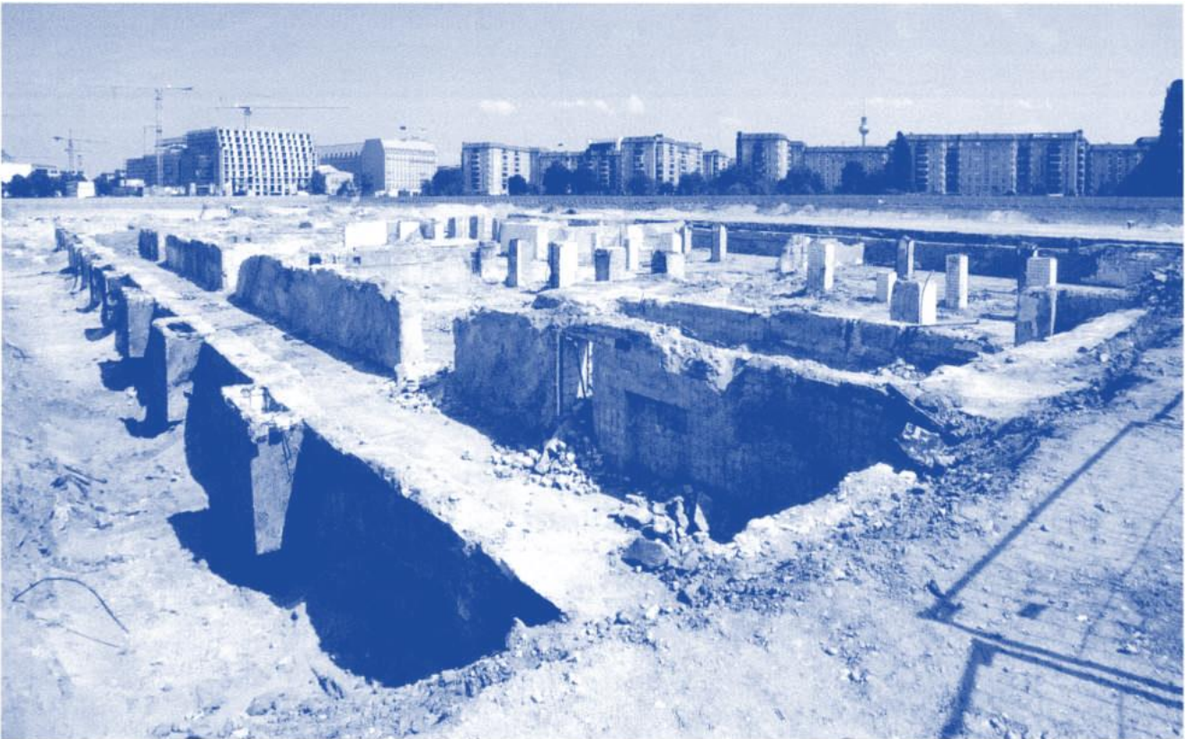
Bei einer Tiefenenttrümmerung 1997/1998 stiess man an der Ebertstrasse (ehemals Hermann-Göring-Strasse) auf die Kelleranlagen der Wachmannschaftshäuser sowie die Reste der Tiefgarage und der Werkstätten der Neuen Reichskanzlei.
