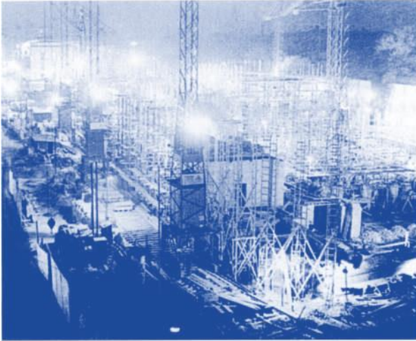
Die Neue Reichskanzlei wurde in Tag- und Nachtschichten errichtet, in der Bildmitte der Rohbau des Mosaiksaals.
