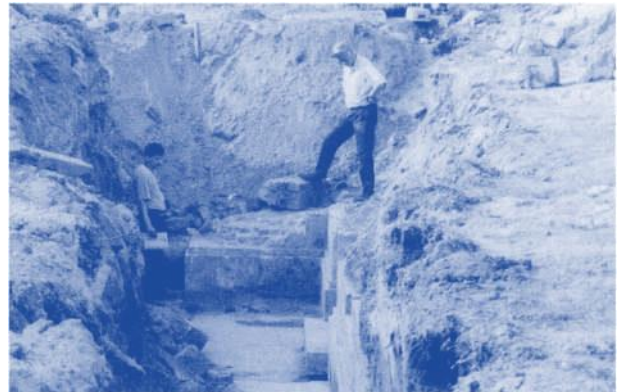
Im Auftrag des Archäologischen Landesamtes wurden 1993 Fundamentreste des Westflügels der Neuen Reichskanzlei (Luftschutzräume) freigelegt.
