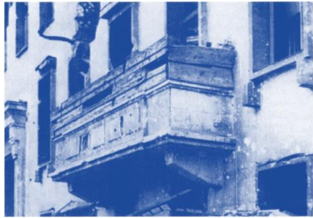
Der 1935 am Dienstgebäude angebrachte «Führerbalkon» wird im März 1945 zur Verteidigungsstellung ausgebaut.
