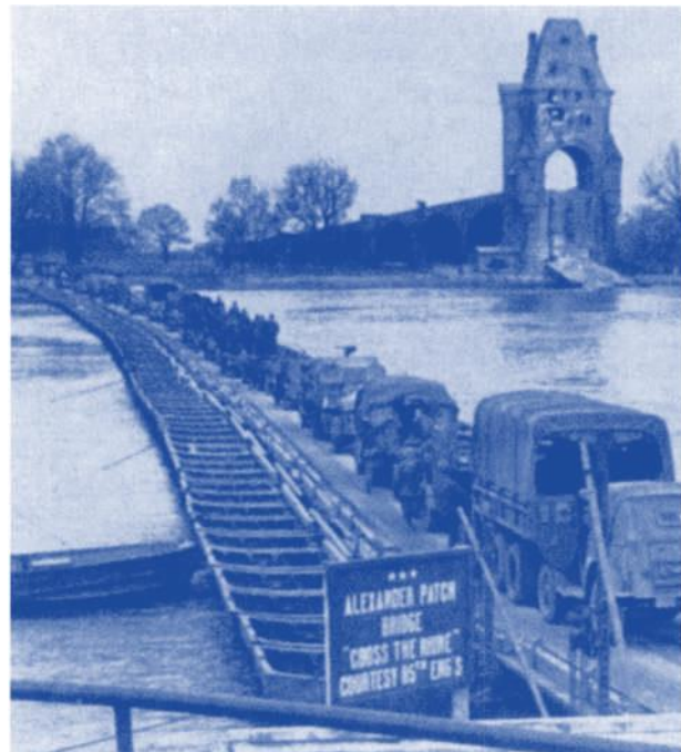
Der Vormarsch der US-Armee ins westliche Reichsgebiet rollt über Pontonbrücken. Diese wurde im April 1945 neben der zerstörten Eisenbahnbrücke von Worms errichtet.
