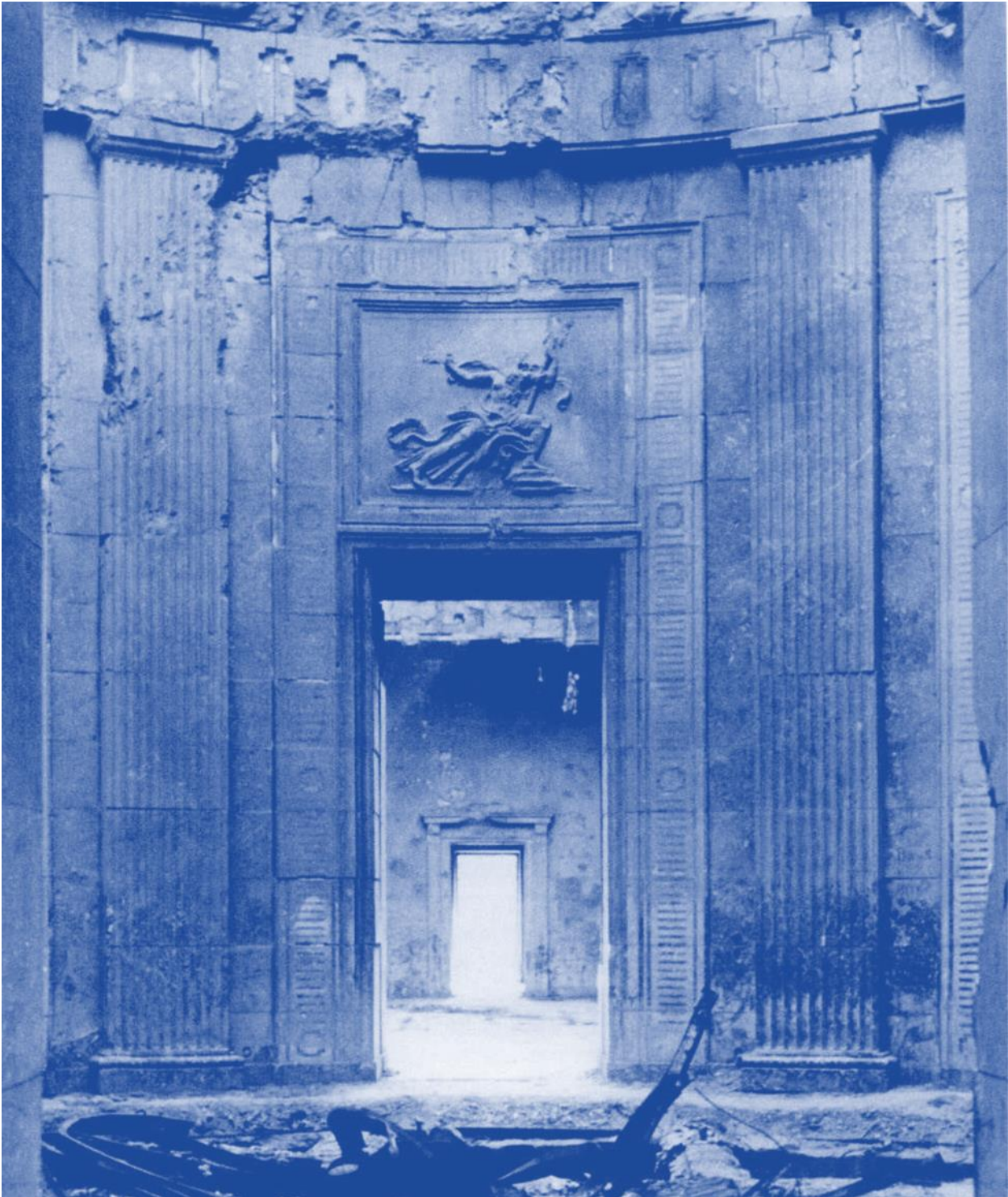
Der zerstörte Runde Saal (mit Blick in den Mosaiksaal) nach einem Volltreffer auf die Neue Reichskanzlei.
