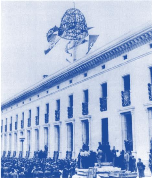
Am 2. August 1938 wurde das Richtfest auf der Baustelle gefeiert, hier mit dem Richtkranz über dem Mitteltrakt.
