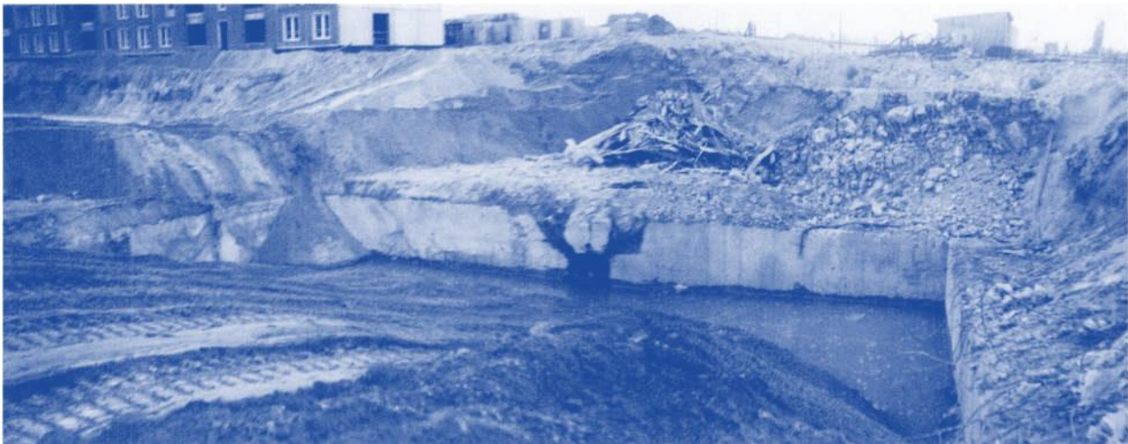
Die Bodenplatte des «Führerbunkers», die sich bis heute unter dem Grundstück an der Wilhelmstrasse befindet. Nachdem Decke und Seitenwände weitgehend abgetragen waren, verfüllte man die Reste mit Sand und Schutt.
