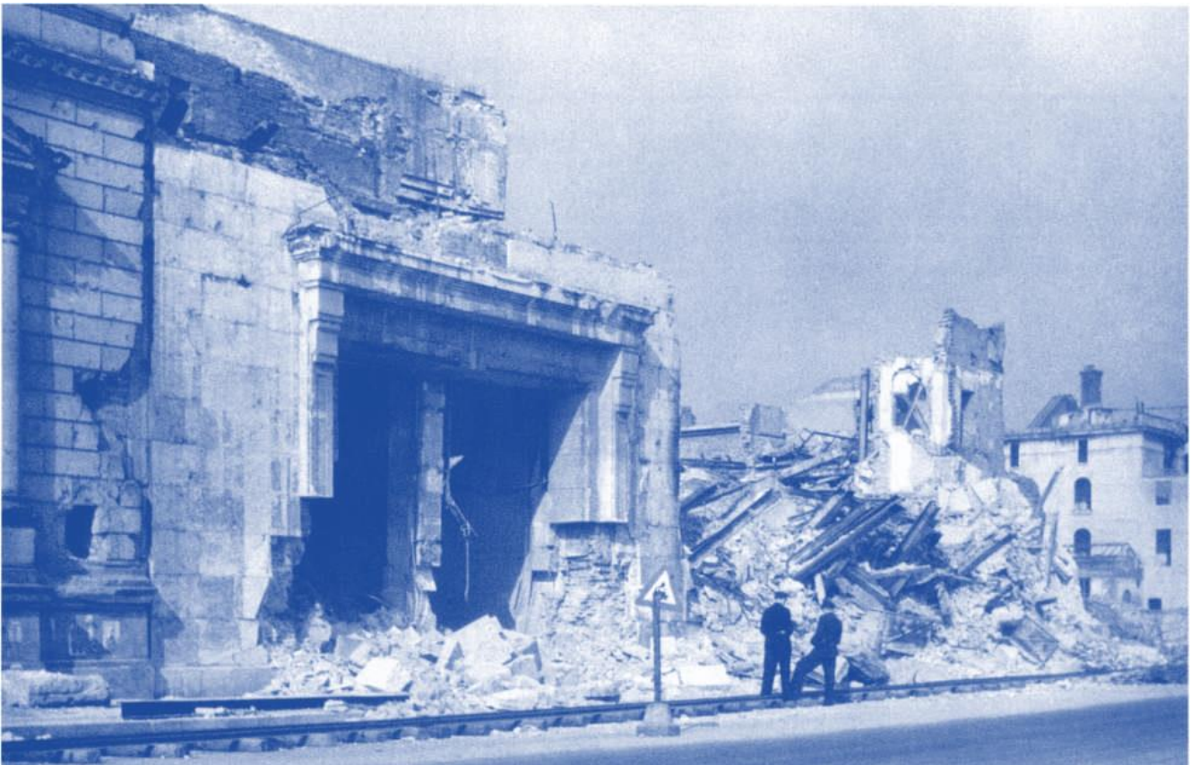
Gleise der Trümmerbahn in der Wilhelmstrasse vor dem im Abriss befindlichen Dienstgebäude.
