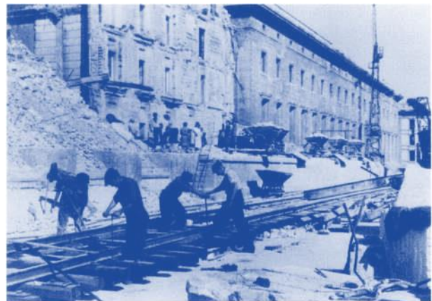
Bauarbeiter montieren während der ersten Abbruchphase 1947 den Schienenstrang für eine Trümmerbahn, die zum Abtransport des Bauschutts aus der Vossstrasse diente.
