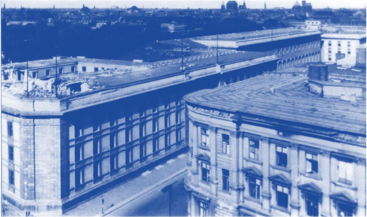
Im Sommer 1943 wurde der Westflügel der Neuen Reichskanzlei erstmals von Bomben getroffen. Die Aufnahme zeigt das durchschlagene Dach an der Ecke Vossstrasse/Hermann-Göring-Strasse.
