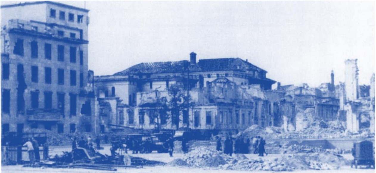
Der Wilhelmplatz im Herbst 1945: Links die Ruine des Dienstgebäudes der Alten Reichskanzlei, daneben die Reste der Alten Reichskanzlei, dahinter das schwer beschädigte Auswärtige Amt.
