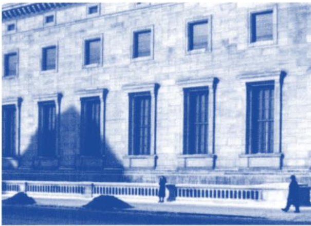
Nach den heftigen Luftangriffen 1942/43 wurden die Fenster im Stockwerk über der Marmorgalerie zum Schutz vor den Druckwellen aussen mit Brettern vernagelt, die Fenster der Marmorgalerie mit inneren Fensterläden verschlossen.
