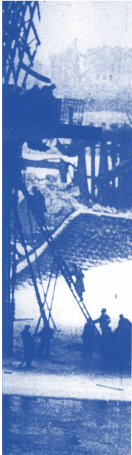
In Polen: Russen bei der Überprüfung der Schäden an einer Brücke über die Weichsel.
