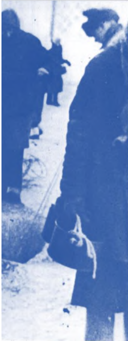
Leningrader füllen aus einem gebrochenen Wasserrohr auf dem Newskiprospekt Wasser in Eimer.
