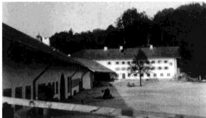
Wohnhaus und Stallungen des 1938 errichteten Gutshofs Obersalzberg. – Christoph Püschner, Hiddenhausen (61) ►
