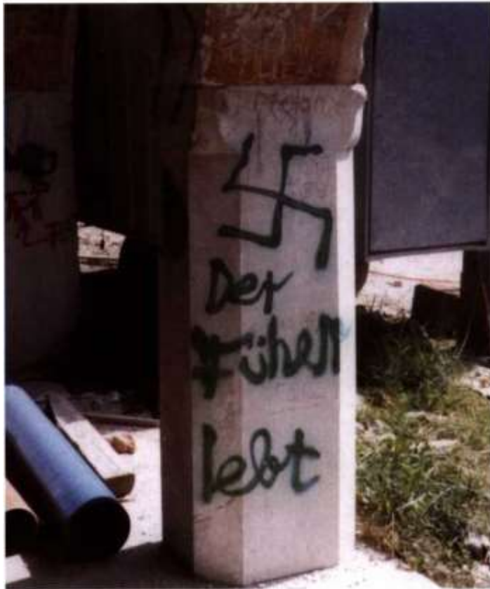
Neonazistische Schmierereien am Rohbau des Gebäudes der Dokumentation Obersalzberg – Privatbesitz Monika Schiller, München (447) ►
