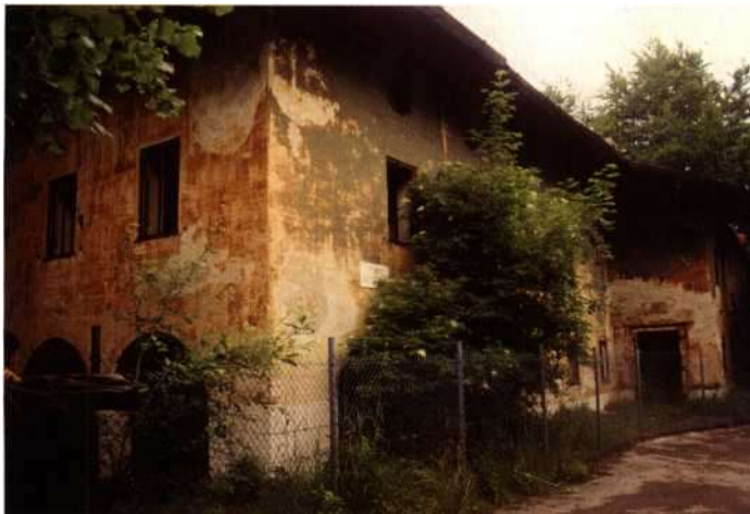
◀ Die Ruine des ehemaligen Gästehauses «Hoher Göll» vor dem Abriss (11. Juli 1996): Auf den Grundmauern wurde das Gebäude für die Dokumentation Obersalzberg errichtet; Teile der Fassade wurden in den Neubau integriert. – Privatbesitz Christoph Daxeimüller, Würzburg (446)
