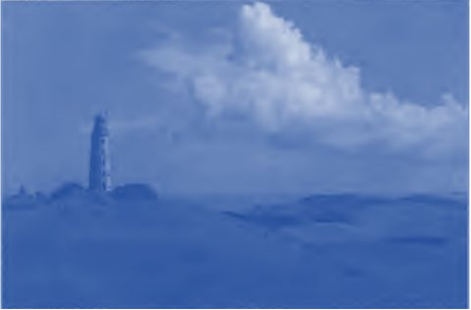
Der 1888 in Betrieb genommene Leuchtturm Dornbusch auf Hiddensee
