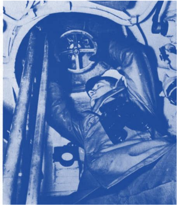
Oben links: Der Kommandant am ausgefahrenen Nachtzielsehrohr in der Zentrale. – Foto: aus [155] • «Alarm»: Das Boot geht auf Tiefe-als letzter der Brückenwache ist der Kommandant in den Turm eingestiegen. Er wirft das Luk zu, das knackend einrastet. Hier dreht er die Spindel und damit das Luk wasserdicht. Inzwischen sind die Entlüfter für die Tauchzellen betätigt worden, traumwandlerisch eingeübt 5 (mit dem Handrad) – 4 beide – 3 beide – 2 beide (alle per Hebel) – und zuletzt 1 (wieder per Handrad). – Foto: PK Lassen • Unten: Die Besatzung von U 65 (Korvettenkapitän Hans-Gerrit von Stockhausen (Ritterkreuz 14.1.1941) nach erfolgreicher Feindfahrt am 2.1.1941 im Stützpunkt. Jeder Mann der Besatzung ist ausgezeichnet worden, denn jeder an Bord ist (nach Wolfgang Lüth) «Mitglied der Kampfgemeinschaft Unterseeboot» [257]. Verantwortung für alle lastet auf jedem Mann an Bord. – Foto: Archiv Koehlers Verlag.
