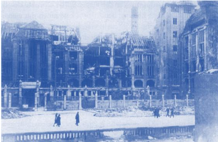
Das zerstörte Wertheim-Warenhaus an der Leipziger Strasse, hier von der Vossstrasse aus gesehen, 1946/47.
