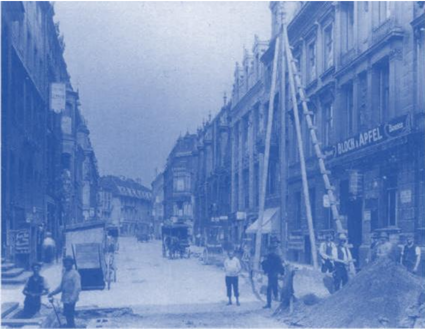
Bauarbeiten in der Alten Leipziger Strasse/ Ecke Niederwallstrasse, 1907.
