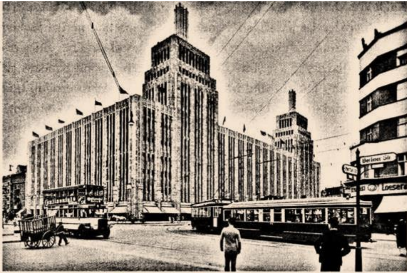
Der im Stil amerikanischer Wolkenkratzer errichtete Neubau von Karstadt am Hermannplatz in Berlin-Neukölln, 1931.
