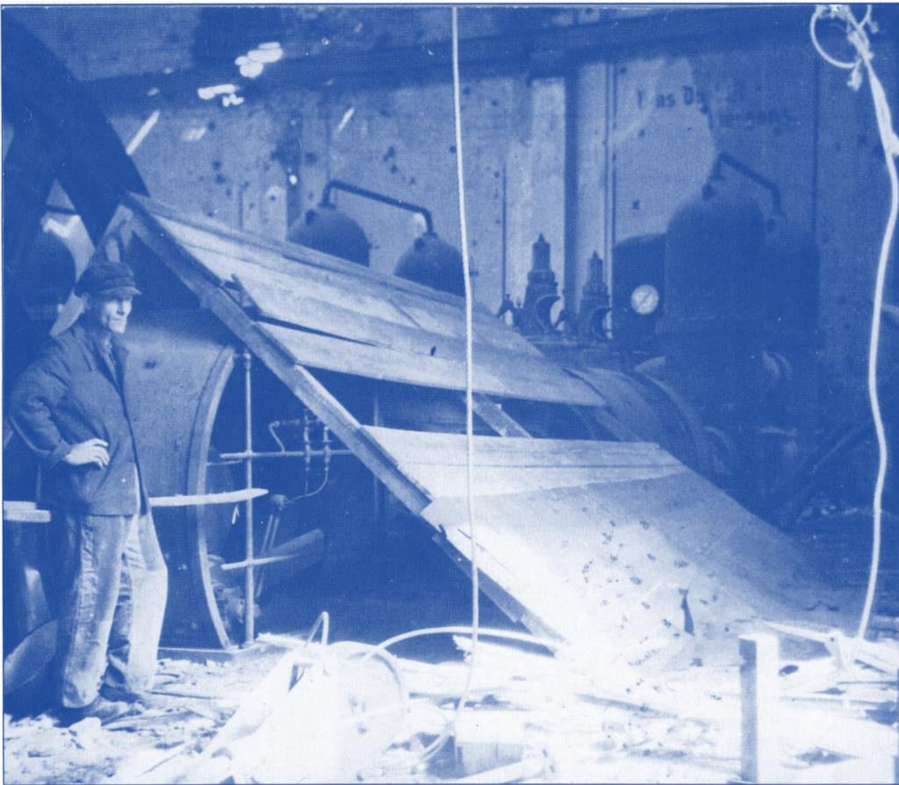
So sah es bei Kriegsende in der Maschinenhalle des Wasserwerks Flehe aus. Betriebsfähig war nur noch eine Elektro-Notpumpe.
