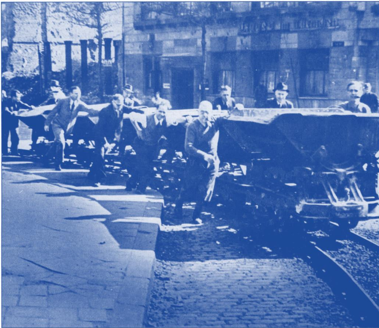
Auch Ratsmitglieder und hohe Verwaltungsbeamte, darunter die späteren Oberbürgermeister Georg Glock (erster in der linken Reihe) und Josef Gockeln (vierter in dieser Reihe), halfen bei den Aufräumungsarbeiten.
