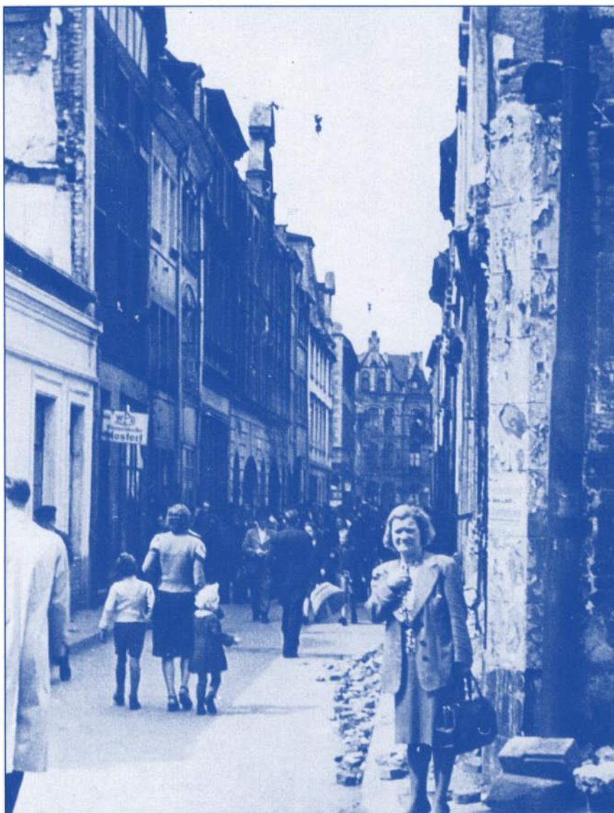
Viele Strassen und Gassen der Altstadt waren bevorzugte Winkel der Schwarzhändler. Auch in der Mertensgasse (unser Bild) traf man sich zu oft riskantem Tauschgeschäft.
