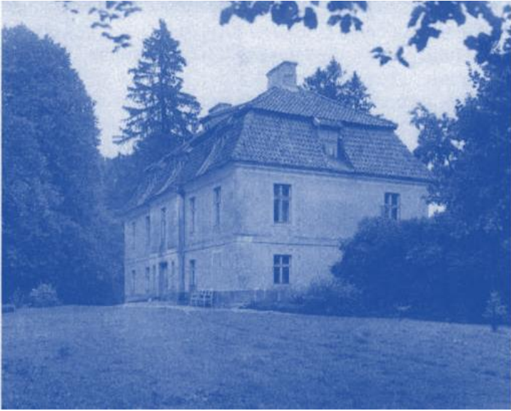
Das Schlösschen Davids wurde 1730 von dem im Ersten Schlesischen Krieg bei Soor gefallenen Burggrafen Alexander Aemilius gebaut. Nach 1945 verfiel es immer mehr, wurde jedoch bis 1980 von einem polnischen Privatmann wiederhergestellt, der es zur Zeit als Gästehaus nutzt.
