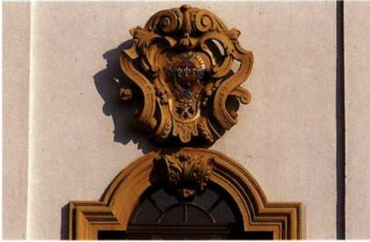
Fassadendetail vom Mittelteil des Gebäudes
