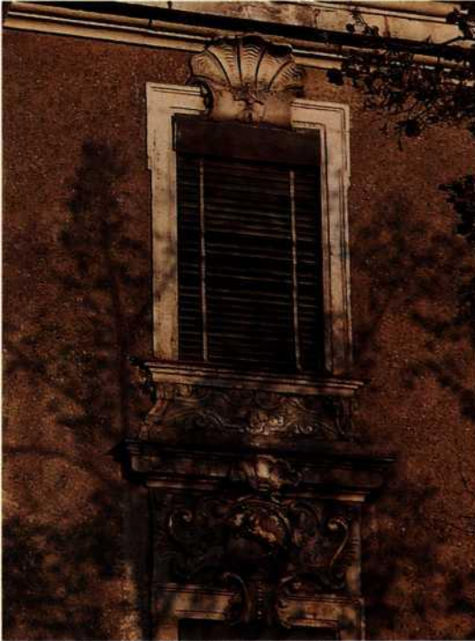
Königstrasse Nr. 7, Fassadendetail
