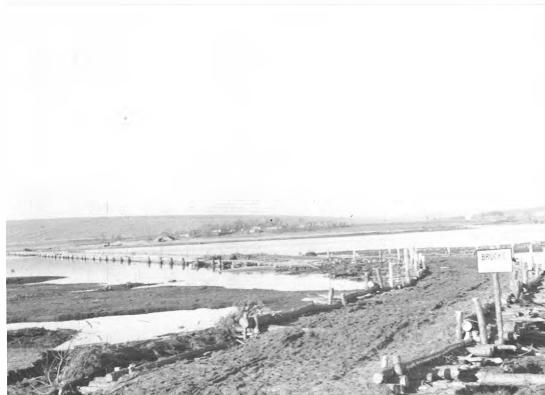
Abb. 61: Eisbruch bei Andrejewka; Vorfrühling 1942.
