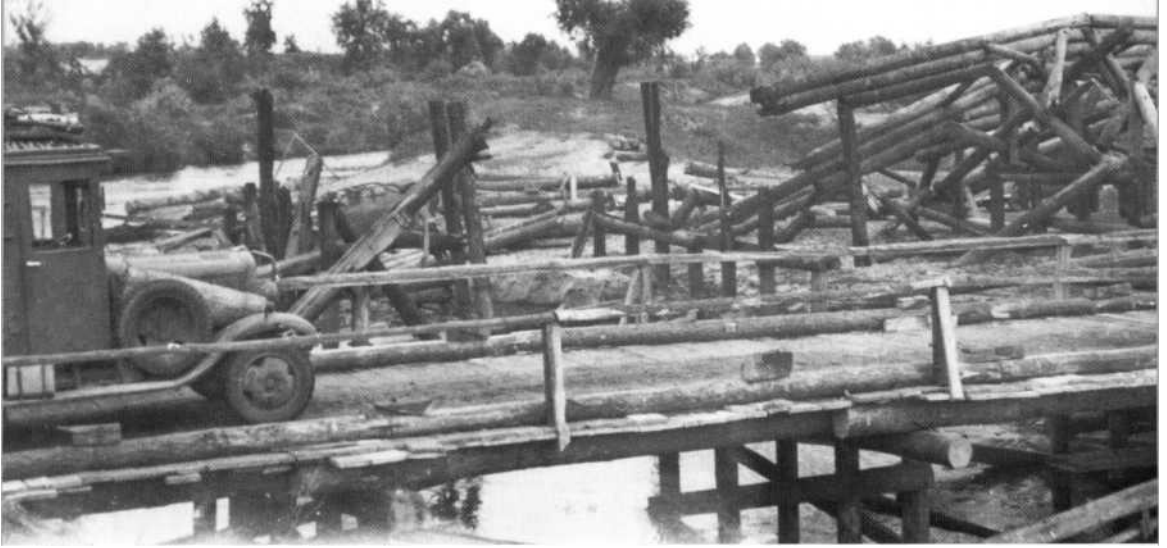
Abb. 110: Bombentreffer auf eine Notbrücke auf dem Weg zum Tschir.
