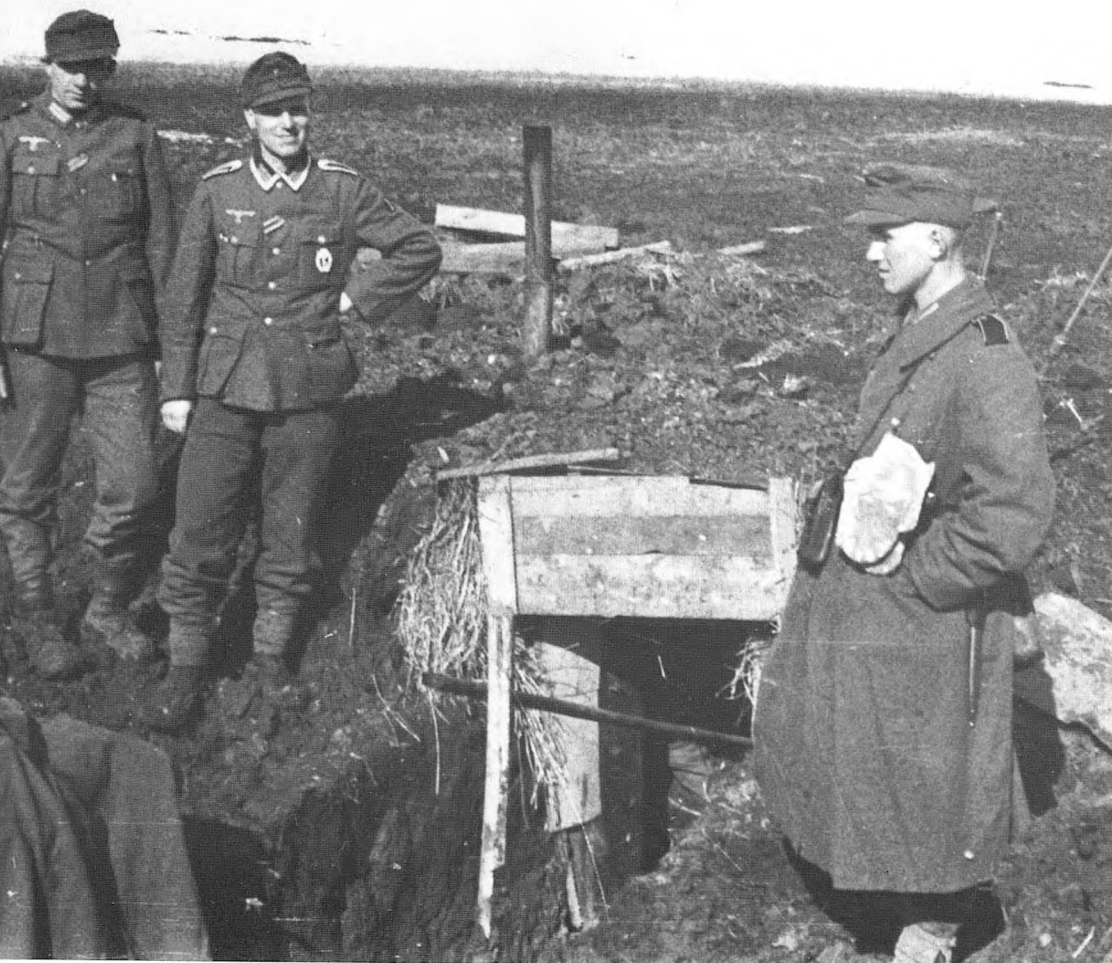
Abb. 18: Der provisorische Bunker, Höhe 107,5.
