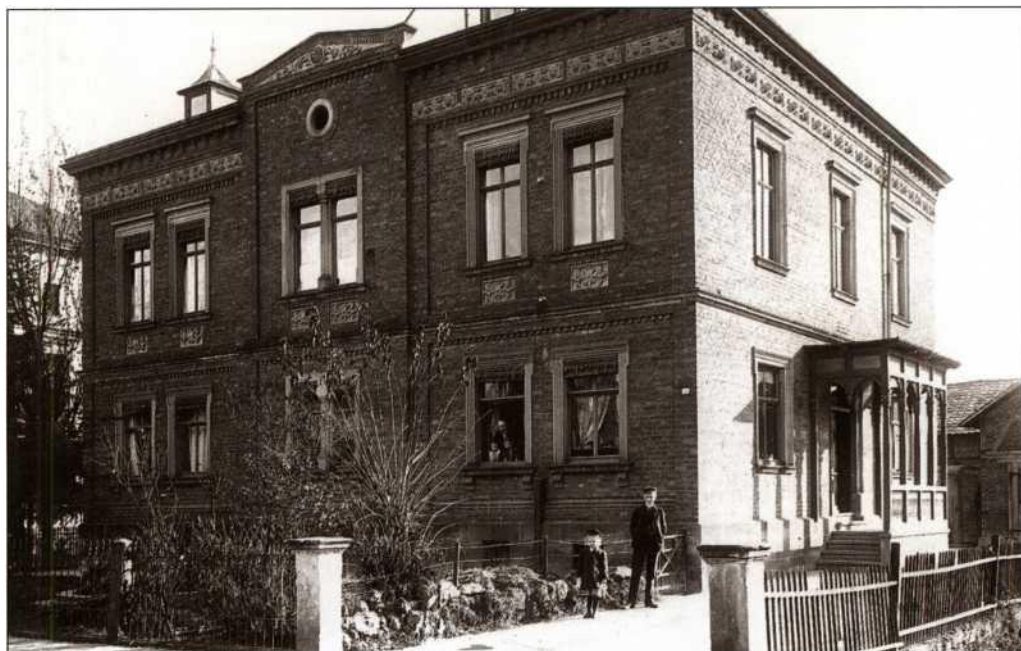
Die Villa des Bauunternehmers Sigmund Leffler in der heutigen Rückertstrasse ist ein schönes Beispiel für die in der zweiten Hälfte des 19. Jahrhunderts in der Stadt aufkommenden Backsteinbauten.
