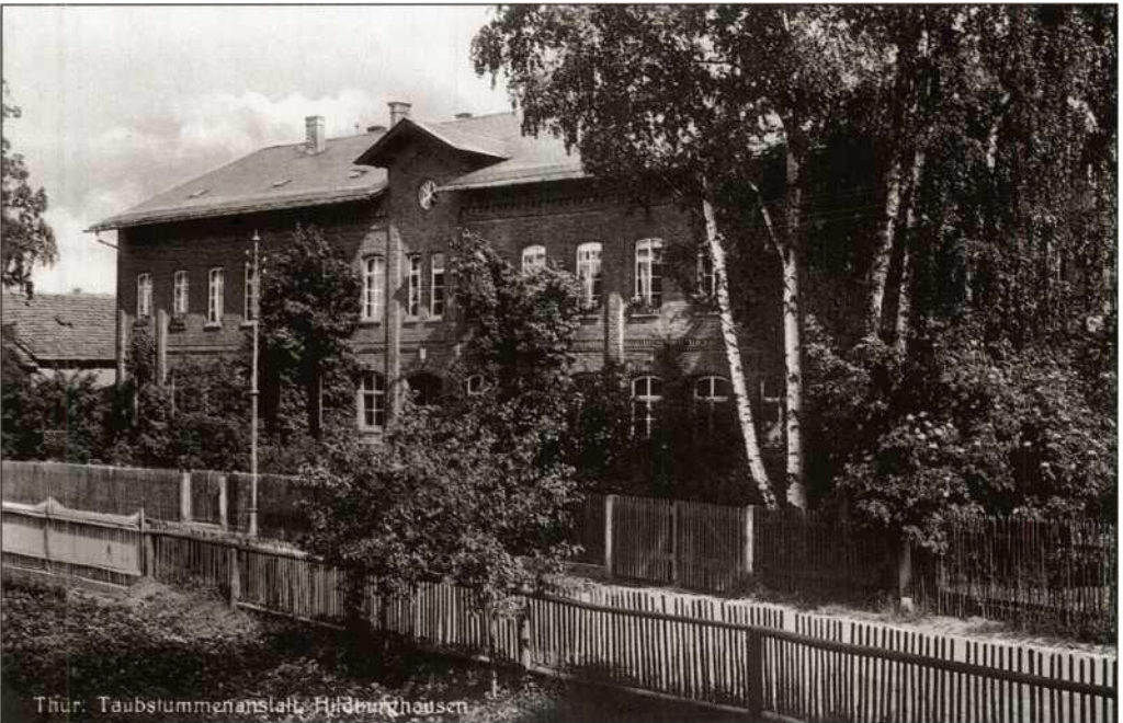
Die Taubstummenschule war 1842 als Nebenanstalt des Lehrerseminars gegründet worden. Das Gebäude, in dem sich die Schule von etwa 1906 bis 1934 befand, wird heute von der Polizeiinspektion genutzt.
