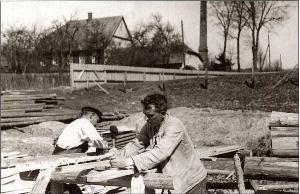
Arbeiter beim Hobeln der Planken, mit denen der Beckenrand des Bades damals verkleidet wurde.
