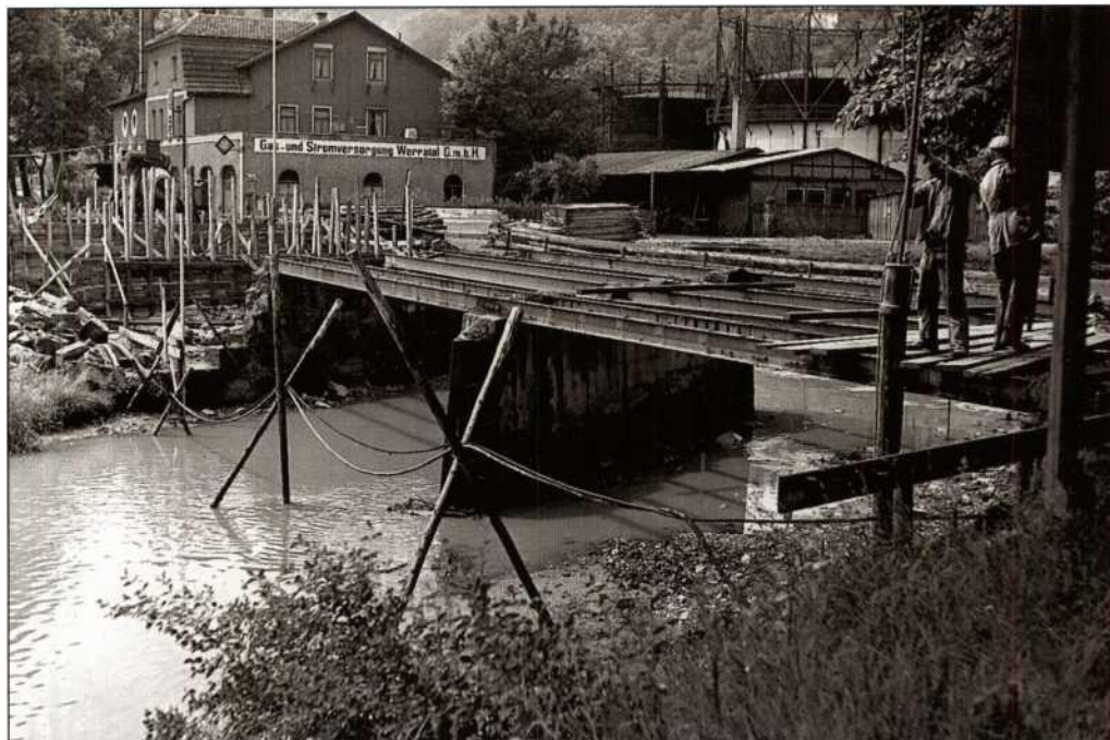
Auch die zweite Werrabrücke Hildburghausens wurde in den dreissiger Jahren neu errichtet. Im Hintergrund der Aufnahme ist noch der Gebäudekomplex der Gas- und Stromversorgungs GmbH zu erkennen.
