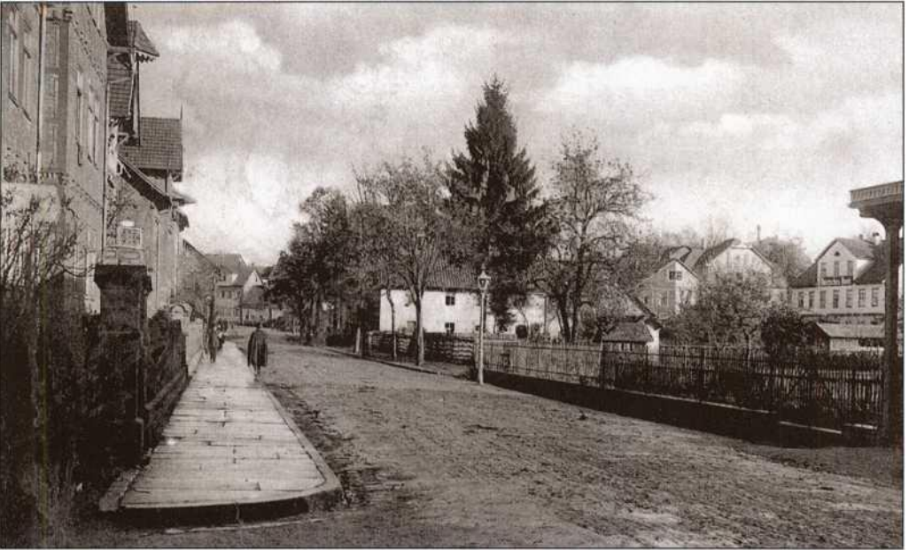
Blick auf die Coburger Strasse vom Theater aus. Die Gebäude wurden Ende des 19. Jahrhunderts errichtet. Ganz rechts im Bild die Gaststätte «Deutsches Haus».
