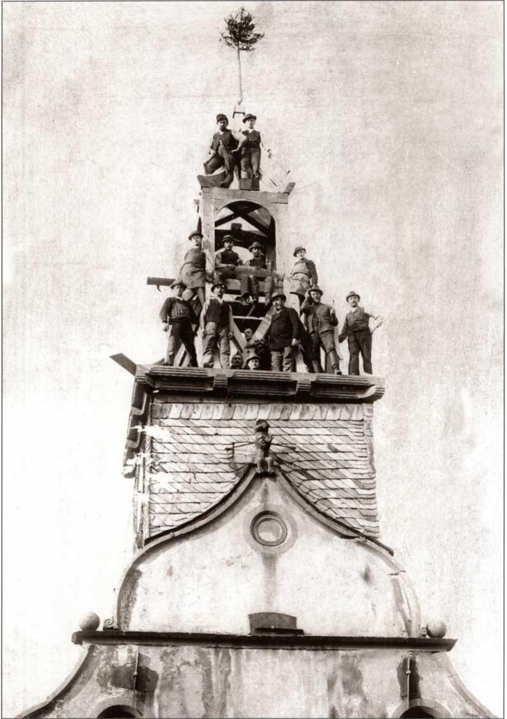
Richtfest für die im Jahre 1900 neu aufgebaute Turmkuppel des Rathauses. Die Arbeiter sind wahrscheinlich Handwerker der Zimmermannsfirma Krieg, die den Bau ausführte.
