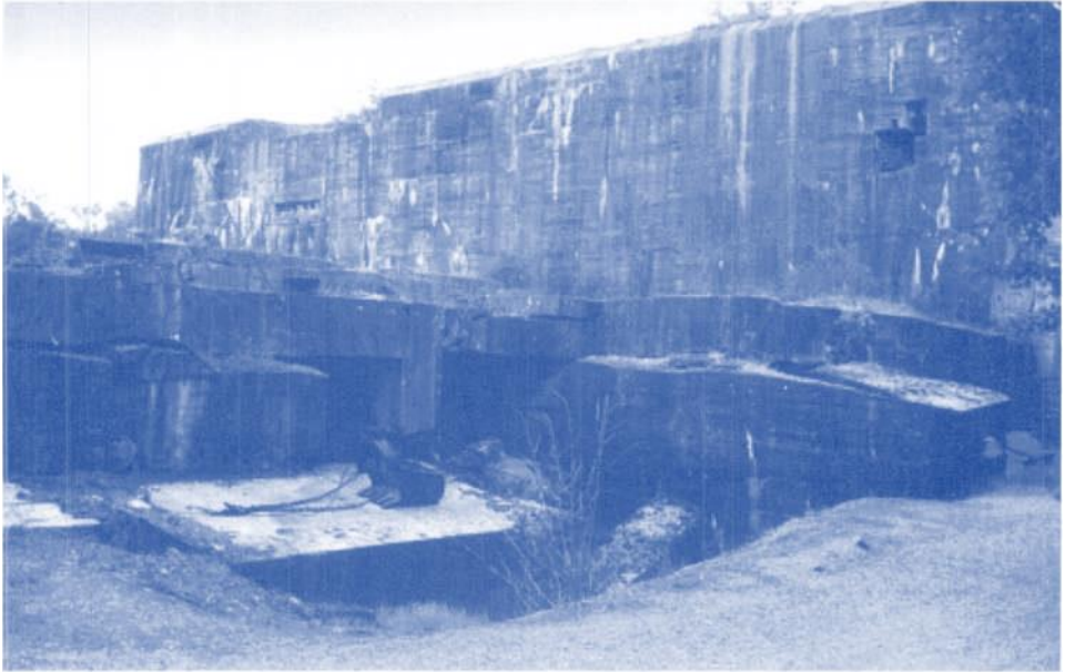
Die Westseite des nördlichen Teils der Anlage von Wattens (Quelle: IBA/ Kurt Grasser)
