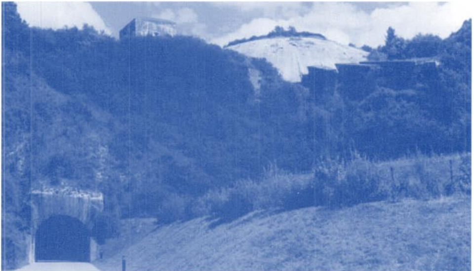
Die gewaltige Anlage B-21 (Wizernes) mit der «Kuppel», dem «Lüftungsblock» und dem Eisenbahneinfahrt-Stollen mit der Bezeichnung «Ida» (Quelle: IBA/Kurt Grasser).
