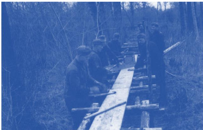
Unser Nageltrupp beim Stege-Bau durch das unwegsame Gelände nahe des Rheins.
