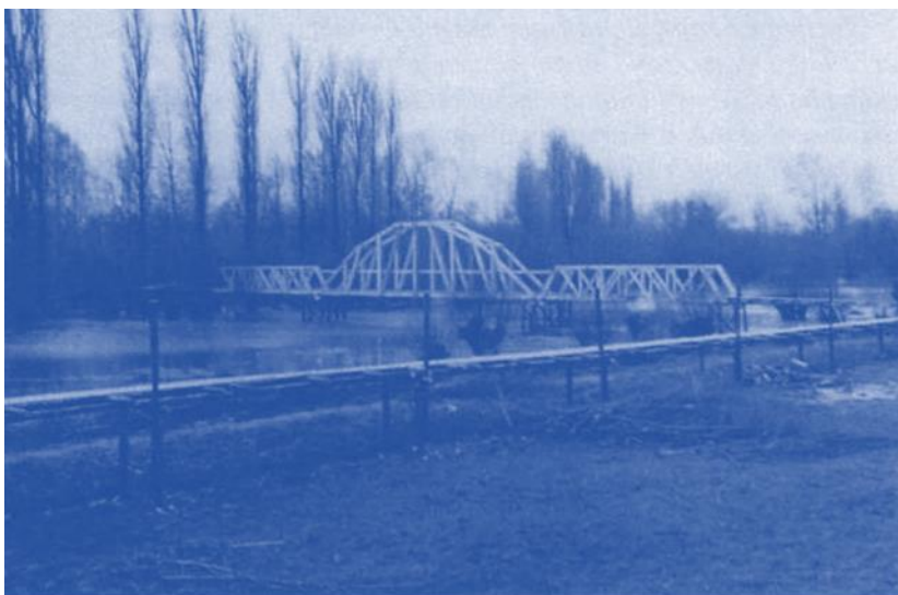
Bis Mitte April 1940 hatte unsere Kompanie auch noch zwei grosse Brücken erbaut (hier die 36 Meter lange Parabelträger-Brücke).
