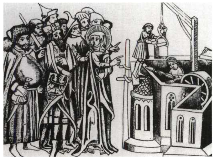
Heinrich I. und seine Gemahlin Hedwig mit Gefolge während der Bauarbeiten der Trebnitzer Kirche
