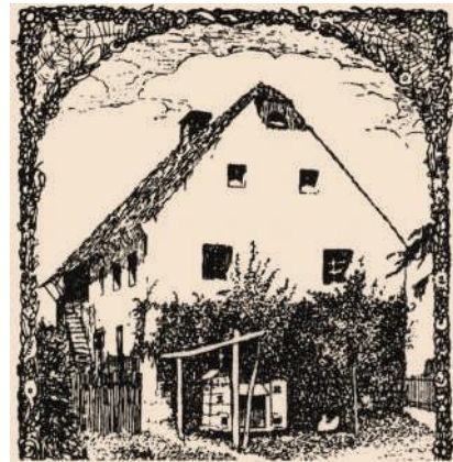
Des Grossvaters Haus in Arnsdorf
