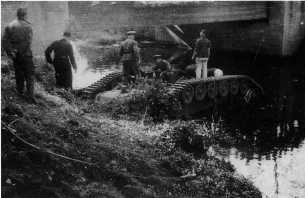
**Mit dem «Kopf» im Wasser:** Nach dem ersten Bergungsversuch liegt der Panzer jetzt auf dem Turm im Wasser. Mit den Abschleppseilen wird er anschliessend von einer Reihe anderer Panzer umgekippt und herausgezogen.
