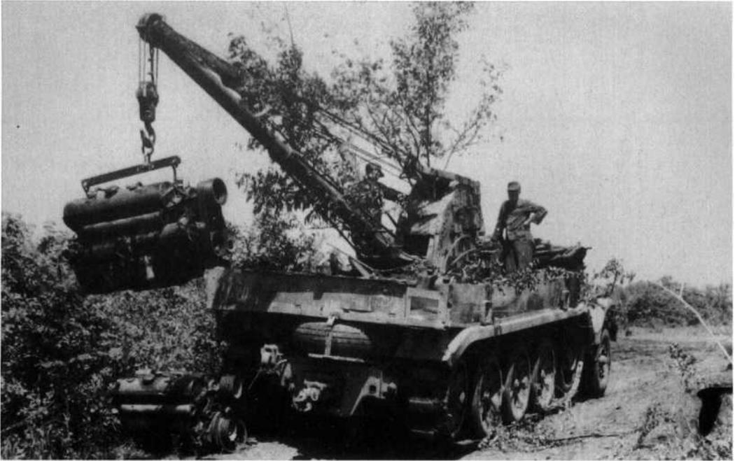
**Motortausch:** Ein stets ersehnter Augenblick der Ruhe hinter der Front. Austausch des Motors am 12.04.1944. Am Kran der Zugmaschine der neue Maybachmotor – Ölkühler- und Lichtmaschinenseite
