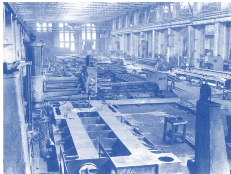
Zu DDR-Zeiten wurde dort der PER Lokomotivbau Elektronische Werke «Hans Reimler» untergebracht, in der Halle IIa die Rahmenfertigung für den E-Lokbau
