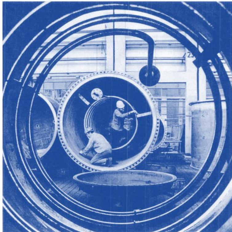
Die Produktion von Investitionsgütern hatte absoluten Vorrang – Montage eines Chemieanlagenbaus
