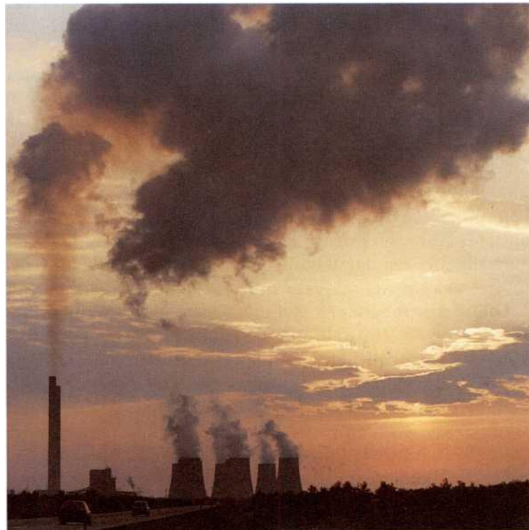
Das Kraftwerk Boxberg: Einst als «Energieriese» und «grösstes Braunkohlekraftwerk Europas» gepriesen, heute Symbol für die jahrelange Verdrängung der Umweltprobleme
