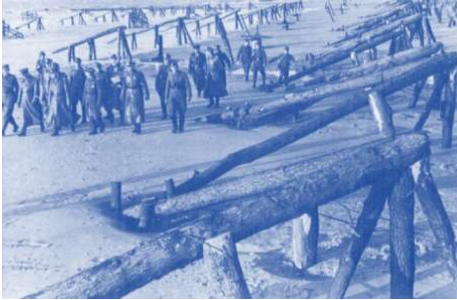
Pas de Calais, Generalfeldmarschall Rommel und sein Stab inspizieren die im Bereich der 15. Armee gebauten Strand- und Panzerhindernisse: vorn die Hemmböcke, im Hintergrund «Tschechenigel» auf Betonfüssen, links «Belgische Tore»
