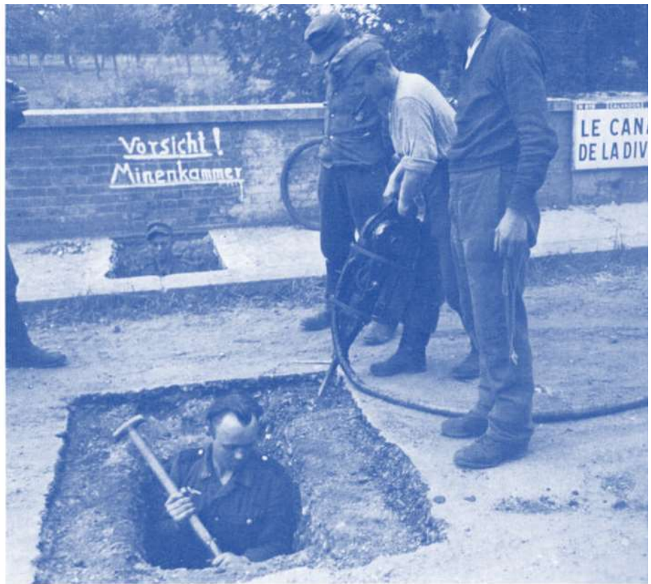
Deutsche Pioniere beim Einrichten von Sprengkammern an der strategisch wichtigen Brücke über den Dives-Kanal südlich von Cabourg (Normandie)
