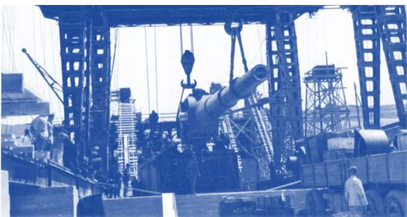
Bau der offensiven Fernkampfatterie «Lindeman» im Pas de Calais: schweres Geschütz vom Kaliber 40,6 cm
