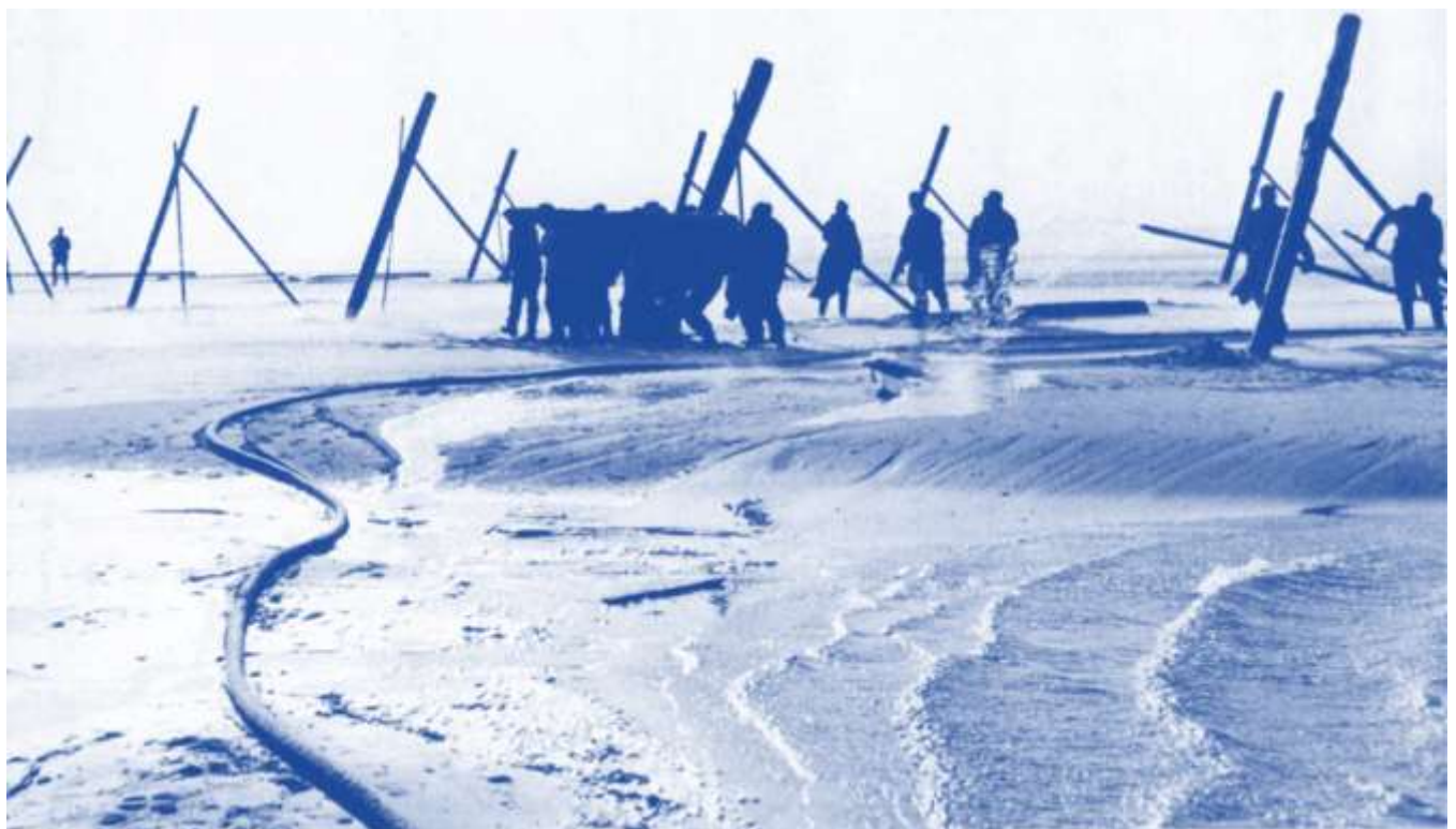
Normandie-Küste. Deutsche Pioniere beim Setzen von Hemmböcken: Das Einspülen der Pfähle mit einer Feuerspritze spart Zeit und Arbeit
