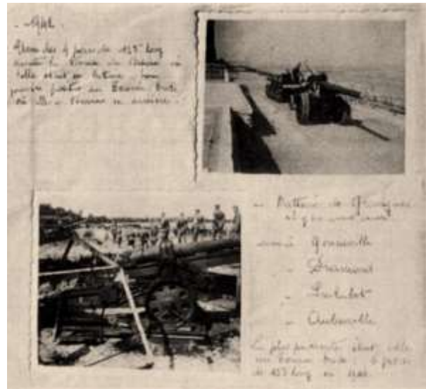
Ein Teil des Berichtes von Monsieur Nicolet: Entstehung der deutschen Heeresküstenbatterie bei Houlgate
