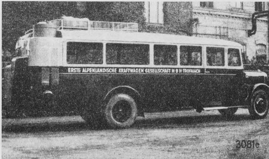
Bild 5. Umgebauter Autobus mit Saurer-Motor BN (Imbert-Gaserzeuger)
