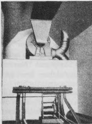
Abb. 38 Kreislauf- und Lüftungseinrichtung einer 400 cbm fassenden Eisenbahntwesungskammer.
