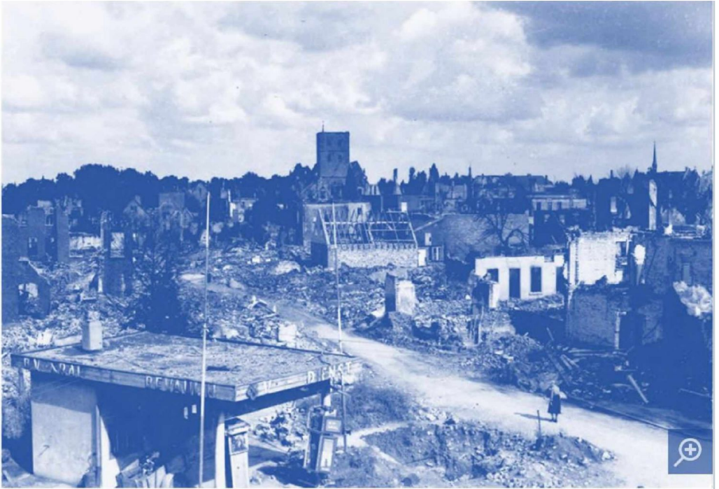
Blick über die zerstörte Innenstadt Richtung Remigius-Kirche, die ohne Turmhaube dasteht
