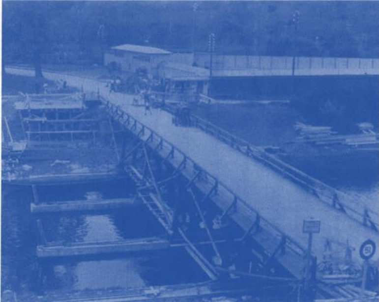
Die Wiesenbrücke. Bildaufnahme; 1935 *Dokumentationsstelle Gemeinde Riehen
