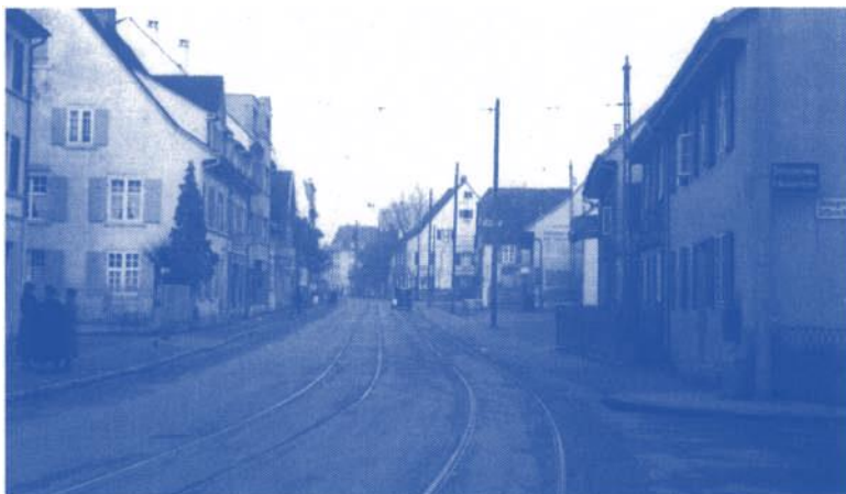
Die Baselstrasse. Bildaufnahme; 1934 *Dokumentationsstelle Gemeinde Riehen, Verfertiger: Amt für Kantons- und Stadtplanung
