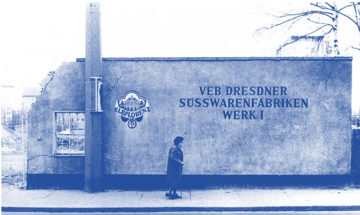
Oben: Eingang zum früheren Stammwerk des VEB Elbflorenz während des Abbruchs Aufnahme: Franz Zadnicek, 1992 Stadtmuseum Dresden, Museen der Stadt Dresden
